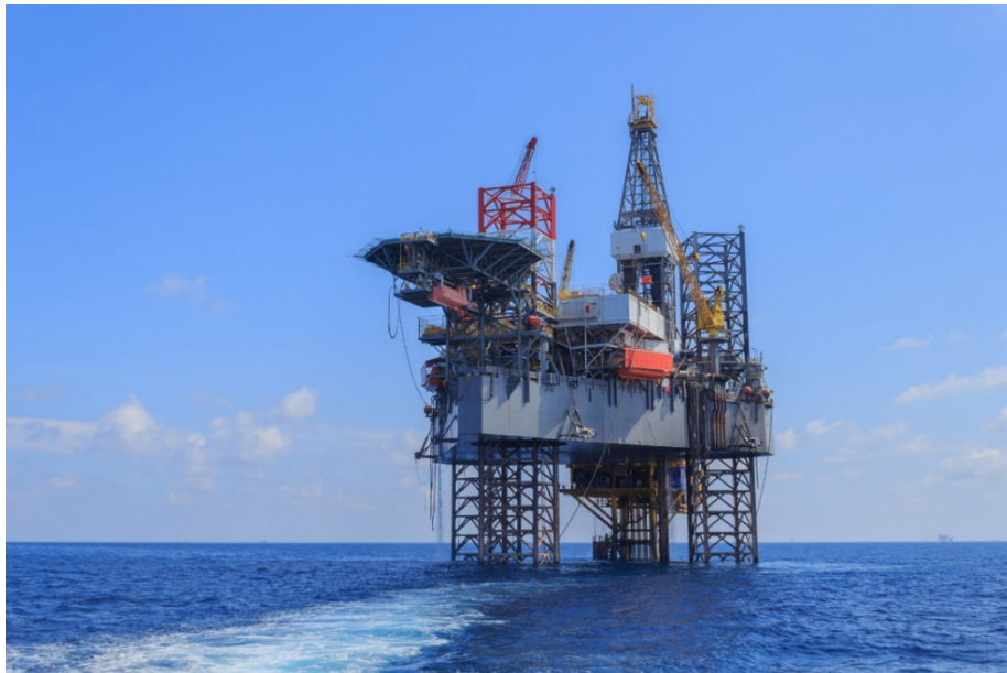
Figura 1.2.2 - Impianto di jack-up. (Fonte: Offshore Adriatico)
