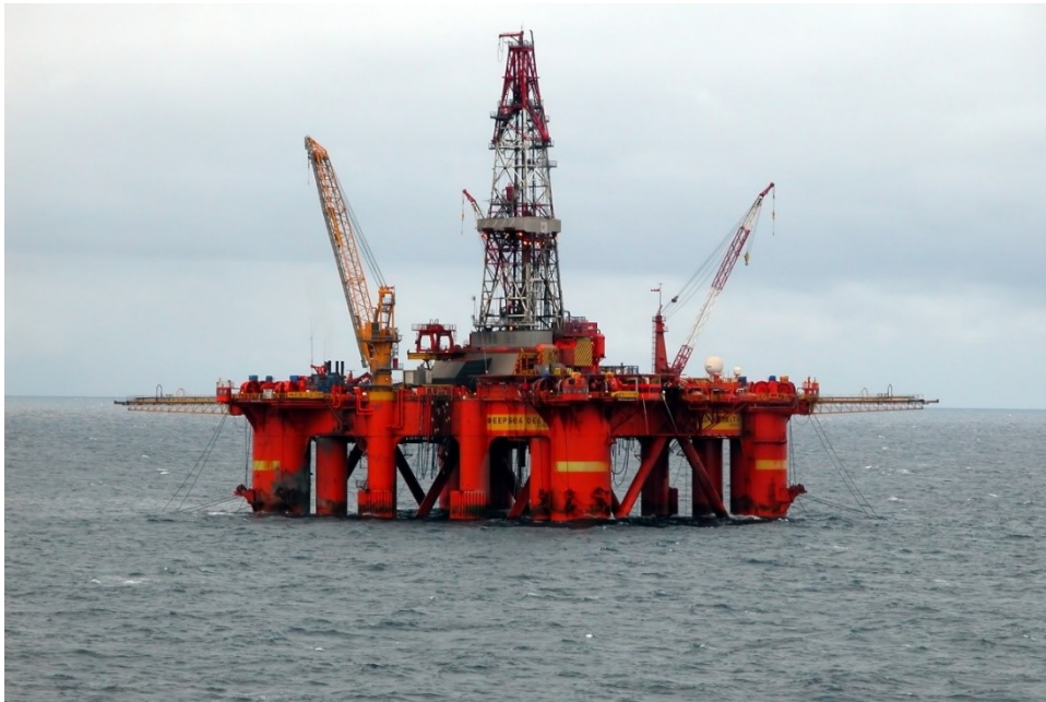
Figura 1.2.3 – Piattaforma semi-sommersibile nel Mare del Nord. (Fonte: Wikipedia)
