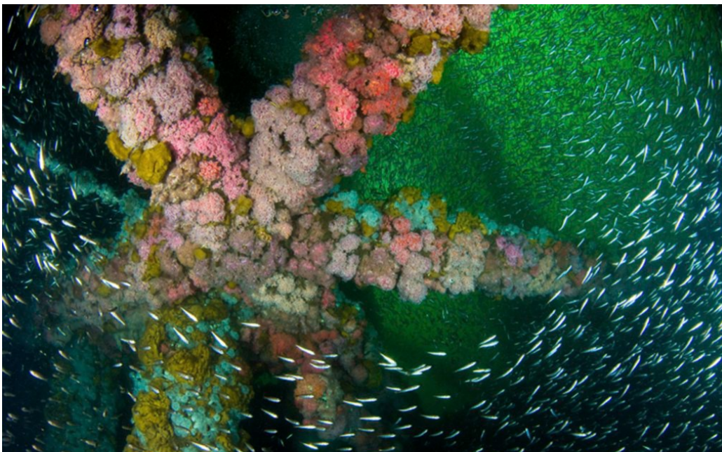
Figura 1.5.1 – Esempio di colonizzazione di un jacket a largo della California (Fonte: “Worldwide oil and gas platform decommissioning: A review of practice and reefing options”)
