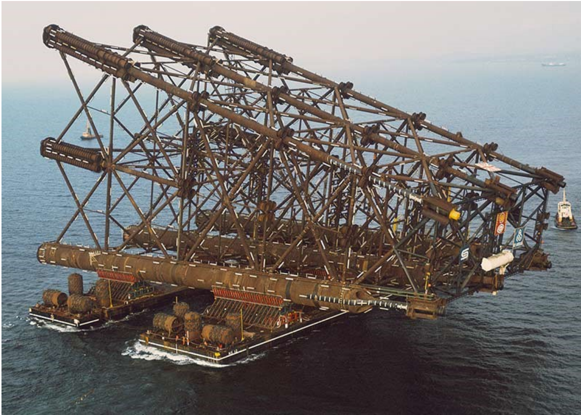
Figura 1.3.5 – Trasporto di un jacket onshore. (Fonte: Cut-group)
