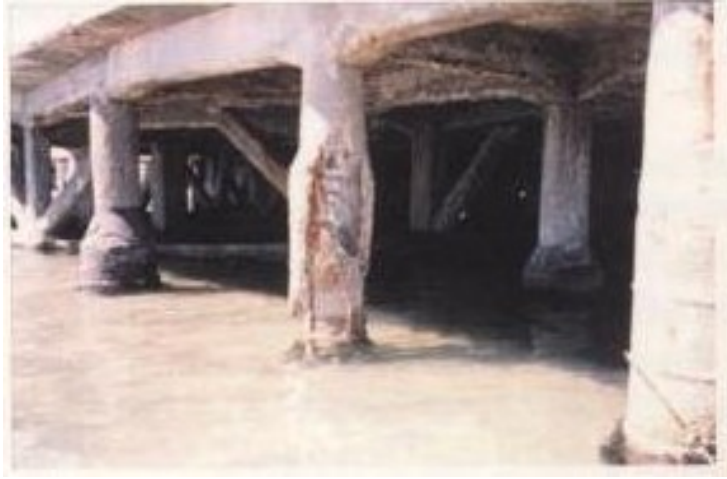
Fig. 51 Corrosione dei ferri promossa dalla presenza del cloruro in acqua di mare [2]
