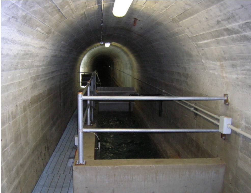
Fig.7 - Galleria a valle (Sorgente di Foce di Montemonaco)
