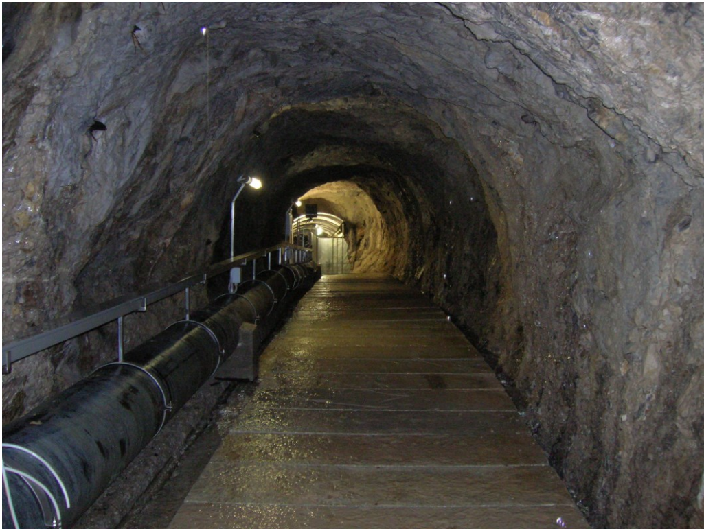
Fig.9a – Visione della galleria (a monte)
