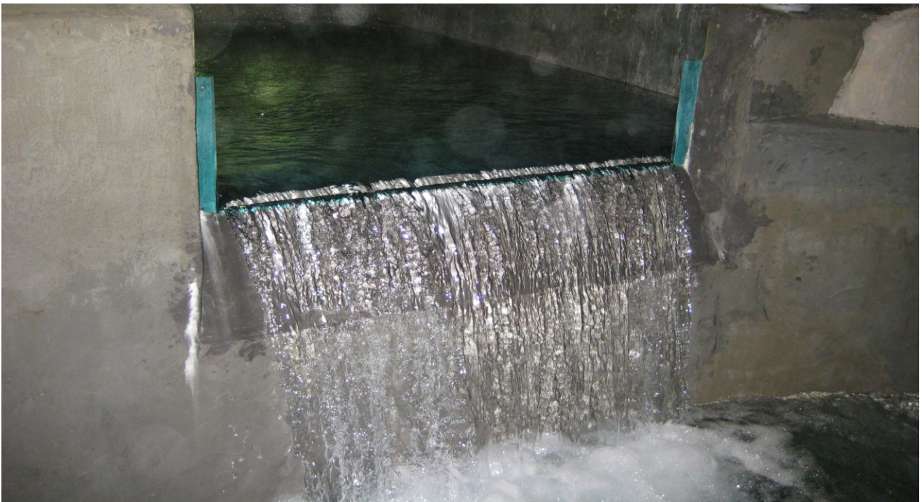
Fig. 5 - Stramazzo (Bazin) ubicato all'interno dell'opera di captazione della sorgente Pescara
