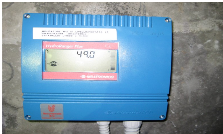
Fig. 27 – Strumento che fornisce il valore di portata
