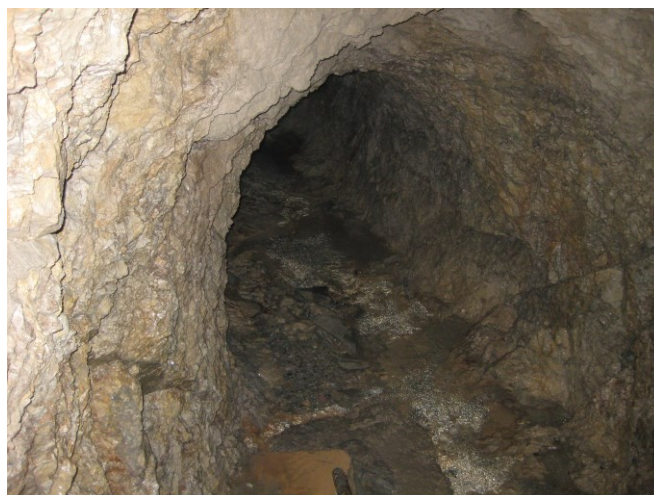
Fig. 24 – Tratto di galleria dell'opera di presa della sorgente di Capodacqua
