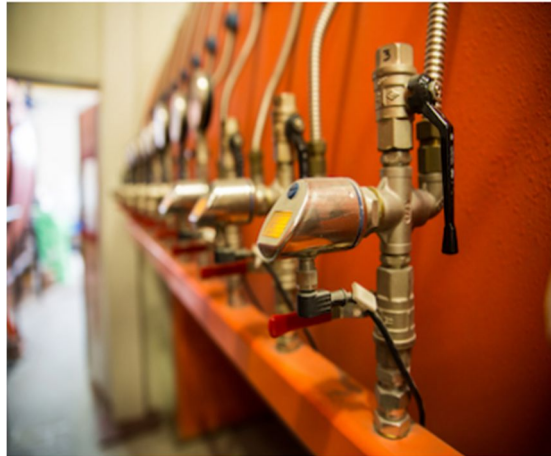
Figura 2.3 Valvole per il vuoto dell'autoclave
