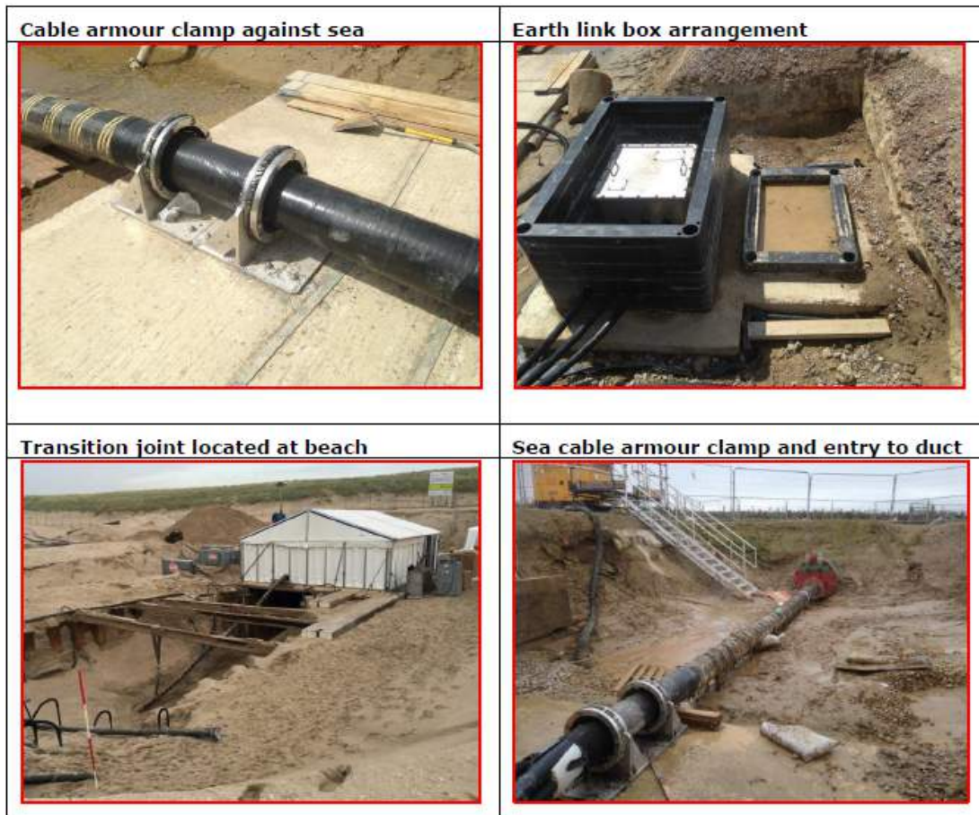
Figura 1.56: varie possibilità di transizione del cavo di esportazione sulla spiaggia [42]
