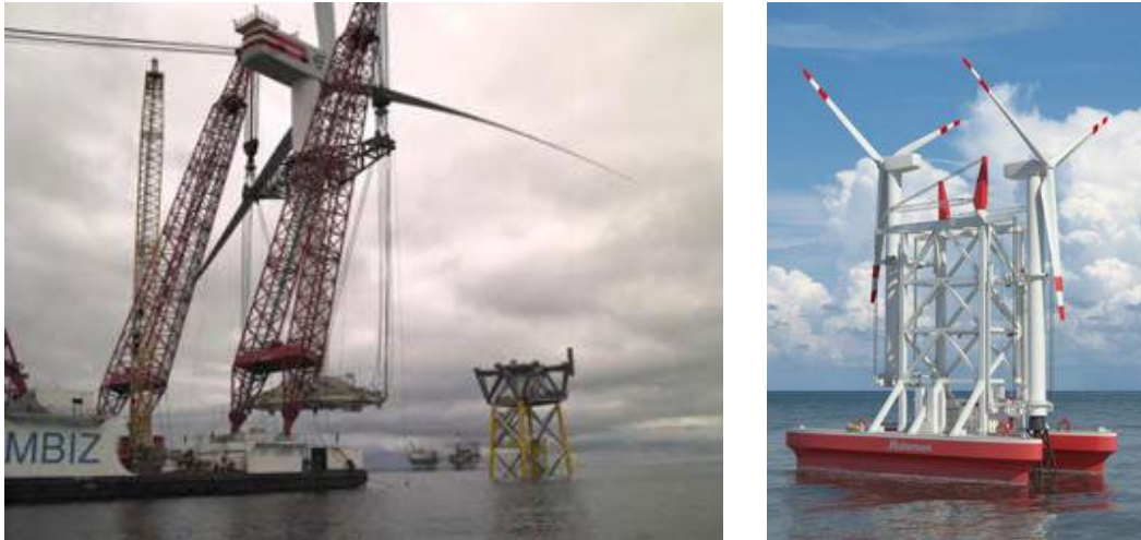
Figura 1.41: Installazione turbina: metodo assemblaggio totale [37]
