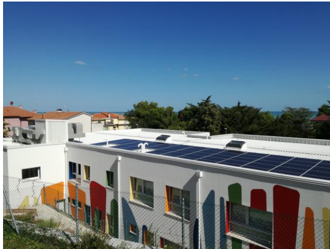
Immagine n°29: pannelli fotovoltaici sul tetto
