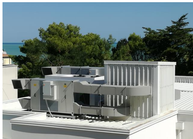
Immagine n°28: pompa di calore posizionata sul tetto
