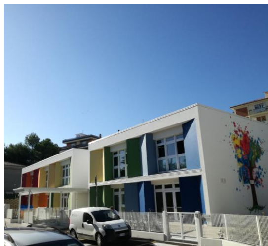
Immagine n°22: vista laterale scuola
