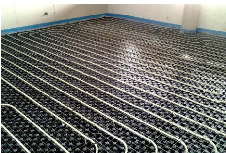
Foto n°62: pavimento radiante
