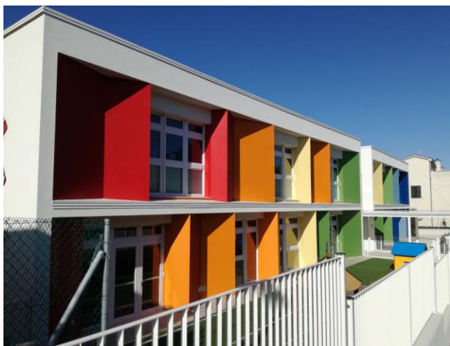
Immagine n°21: vista laterale scuola
