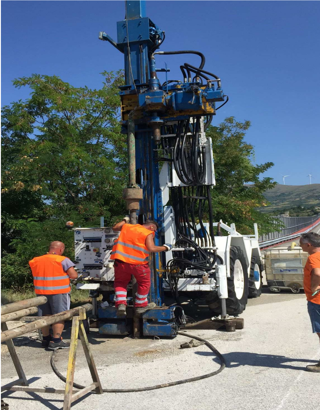
Figura 14: immagine di cantiere esecuzione SPT
