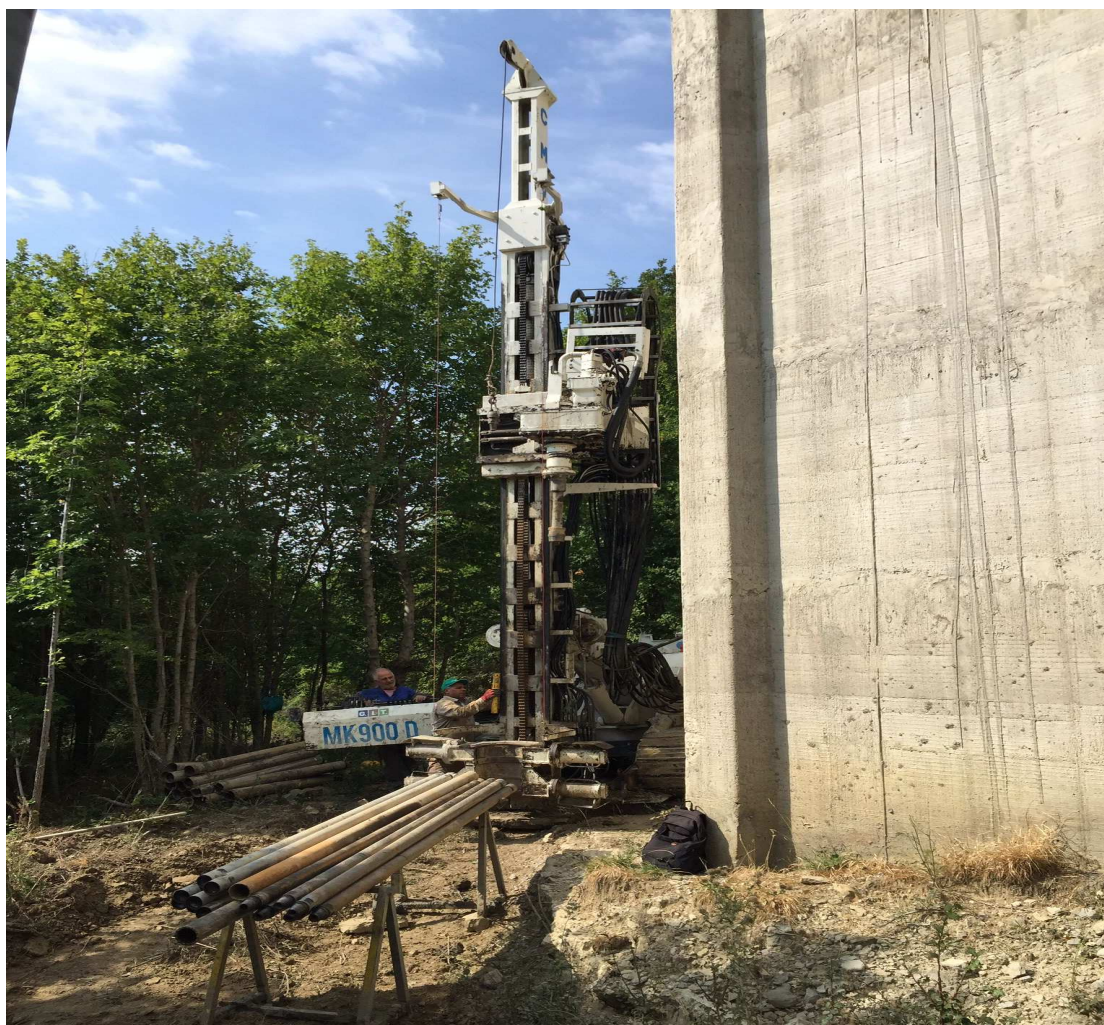
Figura 7: immagine di cantiere durante la realizzazione dei sondaggi
