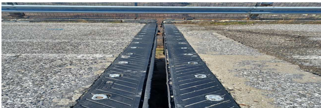
Figura 5: apertura del giunto sulla piattaforma stradale
