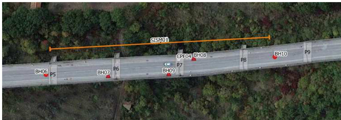
Figura 70: ubicazione monitoraggio inclinometrico nella parte nord del viadotto
