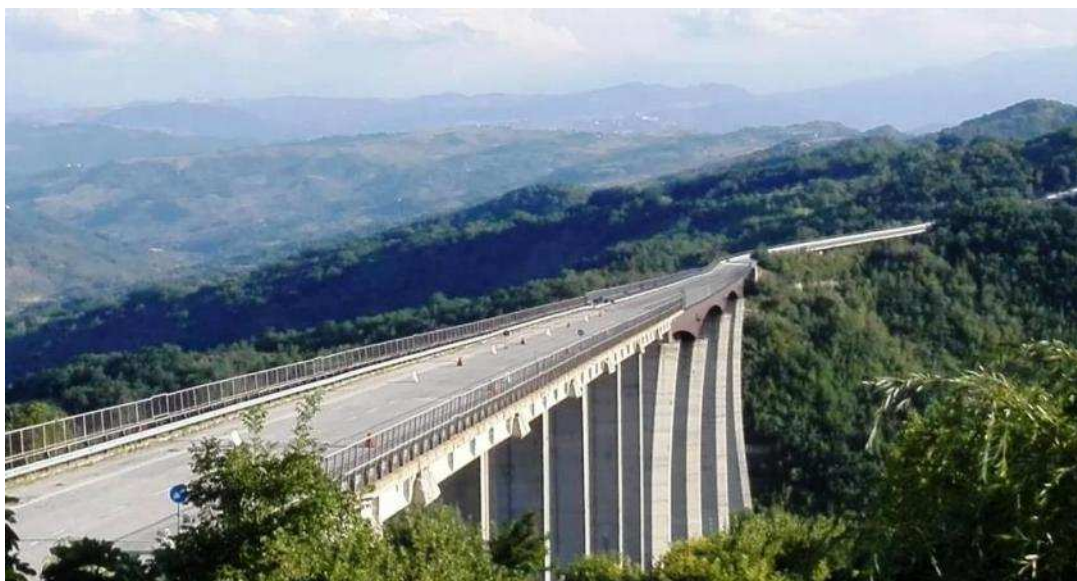
Figura 2: viadotto Sente - Longo
