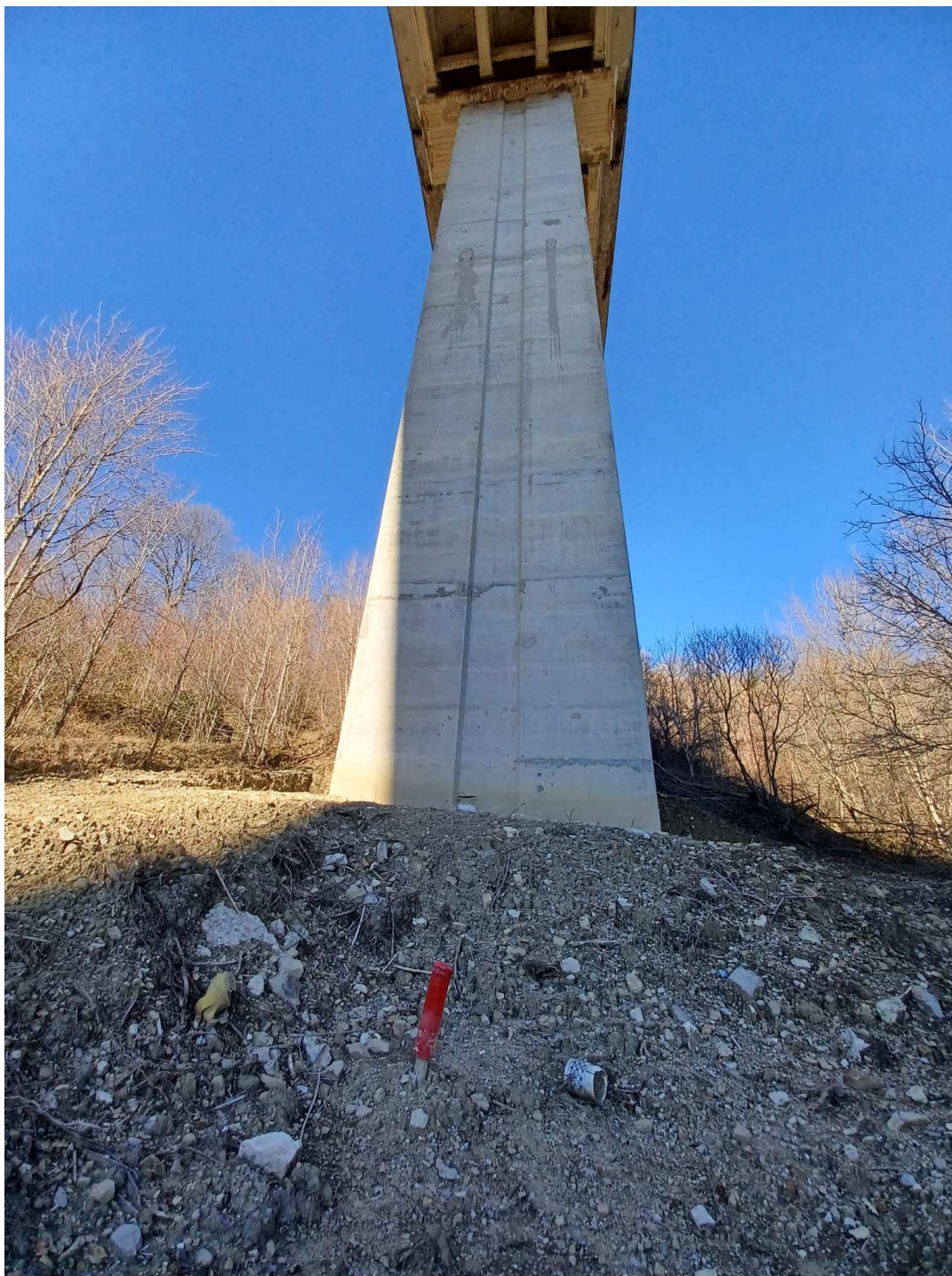
Figura 71: inclinometro installato alla base di pila 7 del viadotto Sente
