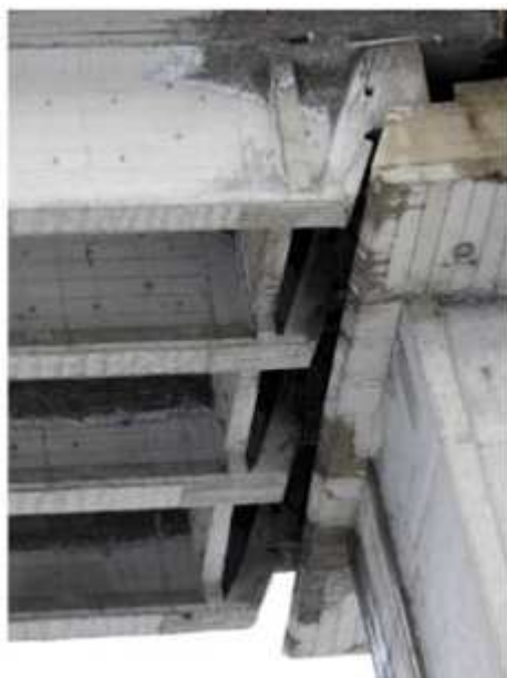
Figura 52: spostamento in testa relativo alla pila 8
