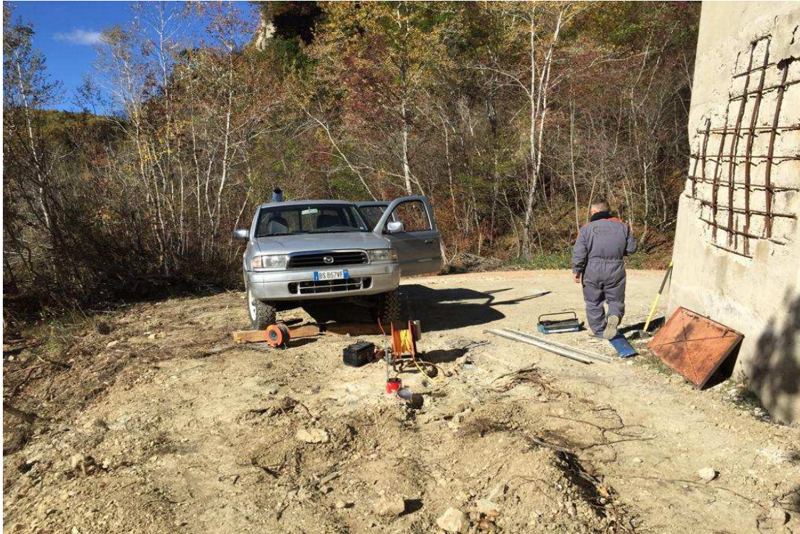
Figura 9: immagine di cantiere realizzazione prova down hole
