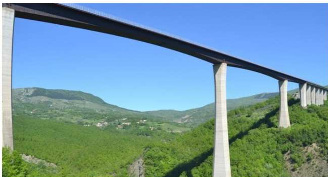
Figura 58: campate viadotto Sente
