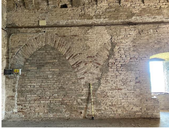
Figura 1.49 - Archi presenti all'interno della muratura del terzo piano del mastio
