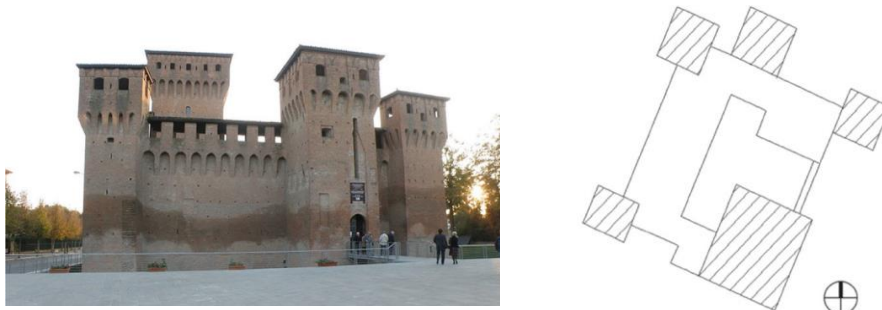
Figura 1.27 - San Felice sul Panaro. Fonte [14]
