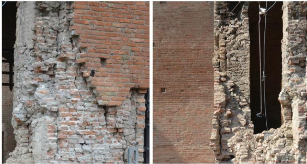
Figura 1.19 - Dettaglio di sezione costruttiva con mancato ammorsamento. Fonte [14]
