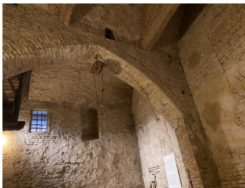
Figura 1.39 - Arco ogivale nel piano terra del mastio
