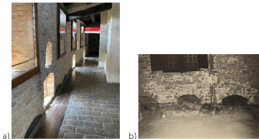
Figura 1.58 - a) Beccatelli esterni che sorreggono il camminamento di ronda rinforzati ad intervalli regolari con mensole di legno annegate nella muratura b) Resti di beccatelli interni al secondo piano. Fonte [35]
