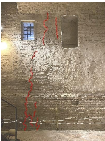
Figura 2.25 - Metodo Comparativo - Esempio Fase 1, Individuazione delle fessure
