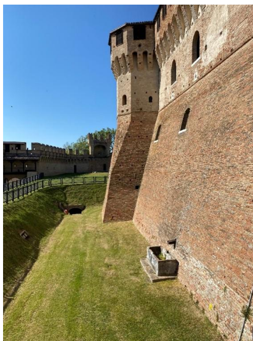
Figura 1.54 - Fossato e scarpa muraria
