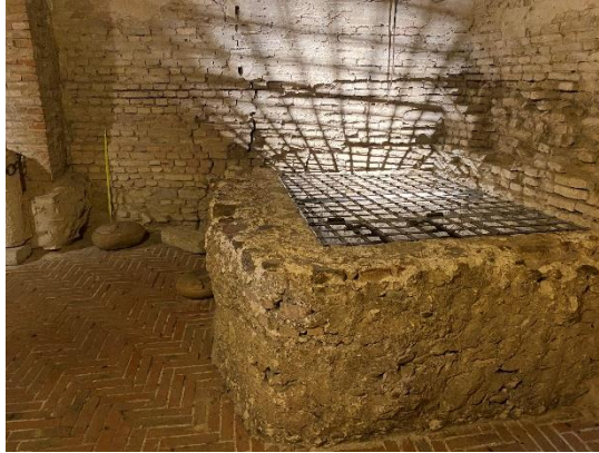
Figura 1.44- Cisterna per la raccolta dell'acqua nel mastio a piano terra
