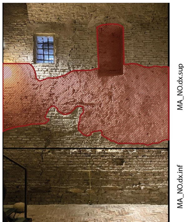
Figura 2.13 - Esempio di Individuazione delle parti non rilevabili e della suddivisione del paramento in riferimento alla parete MA_NO.1.dx
