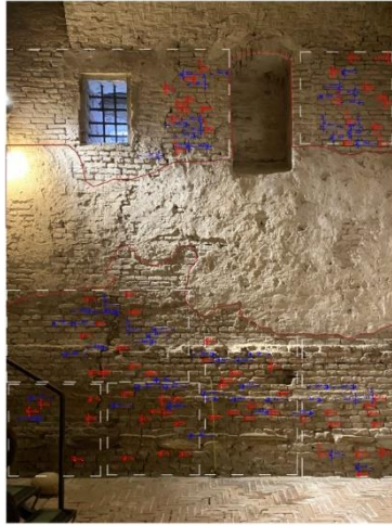
Figura 2.22 - Metodo Ortostati-Diatoni - Esempio Fase 2, misurazione elementi
