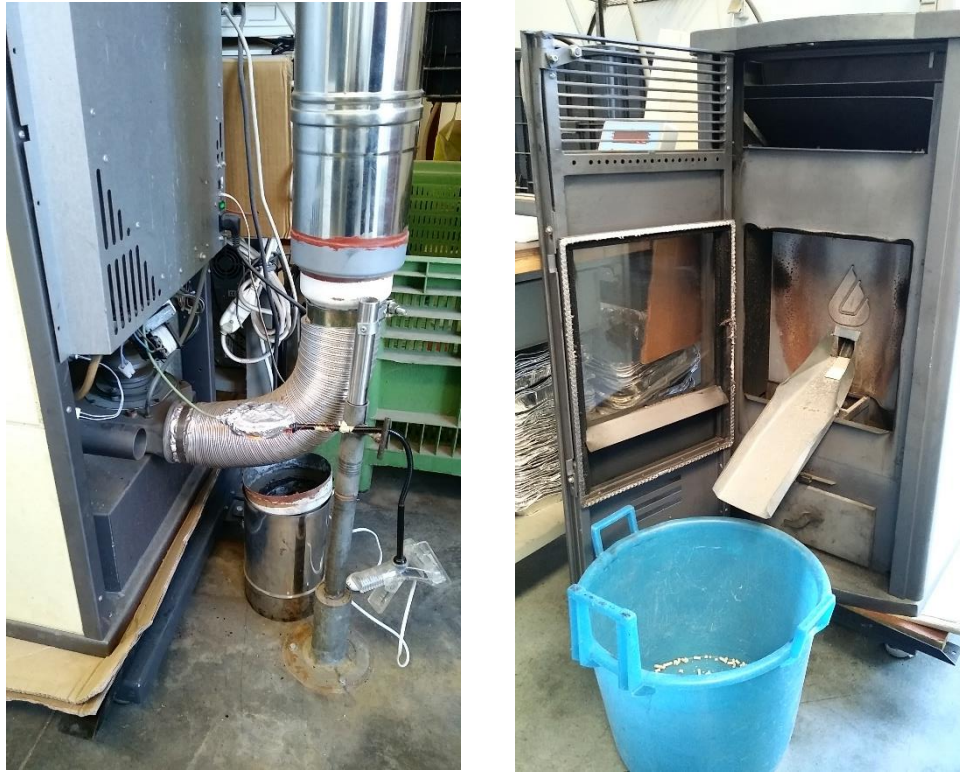
Figura 6 - A sinistra, lampada alogena per il riscaldamento della termocoppia; a destra, scivolo metallico per l'allontanamento del pellet dal braciere.
