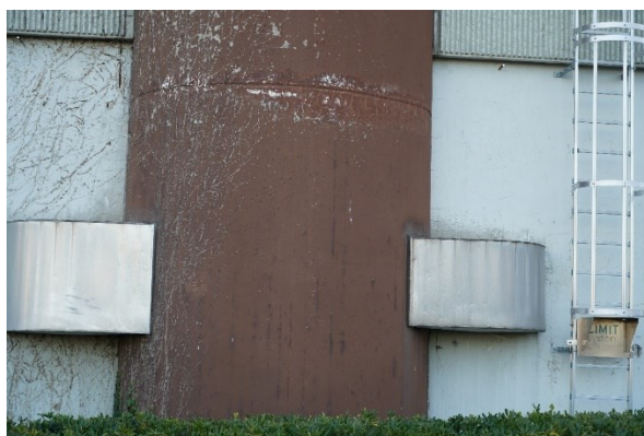
Figura 4-1: immagine della centrale termica originale
