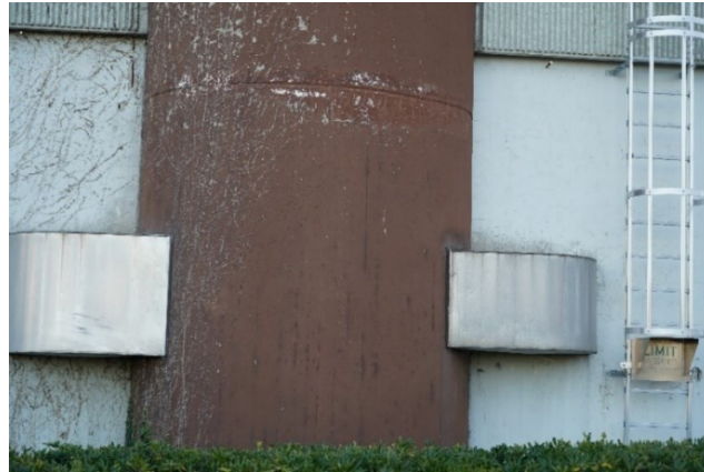
Figura 4-6: immagine della centrale termica originale
