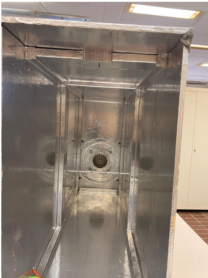
Figura 38 - Tubo all'interno del box
