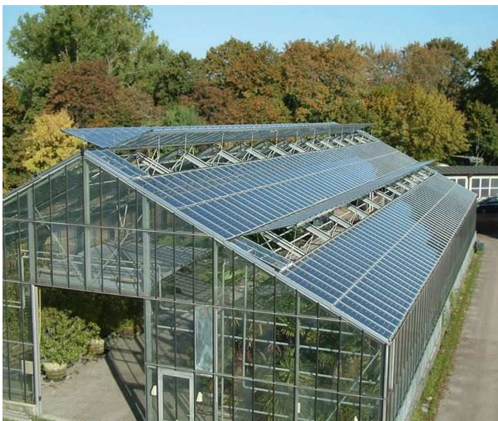
Fig. 5.4. Esempio di serra fotovoltaica. (Fonte: https://www.rifaidate.it )
