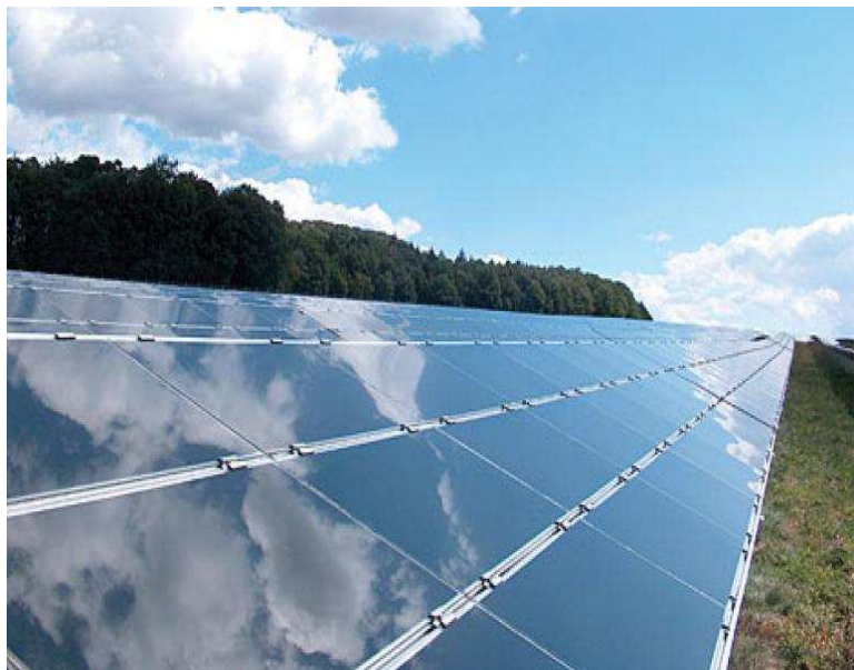
Fig. 4.3. Impianto fotovoltaico con pannelli al tellururo di Cadmio. (Fonte: https://www.fotovoltaicosulweb.it )
