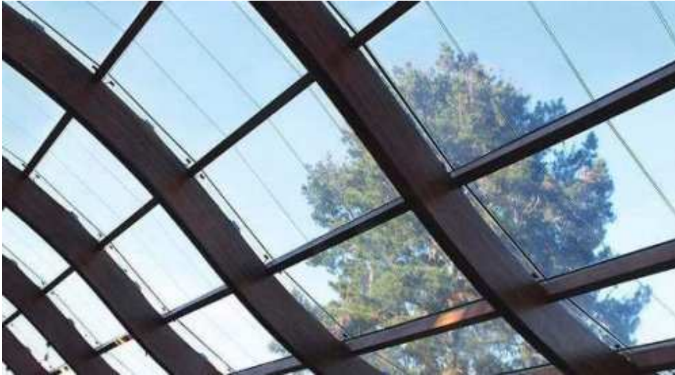
Fig. 5.5. Esempio di tettoia fotovoltaica trasparente. (Fonte: https://www.edilnet.it )
