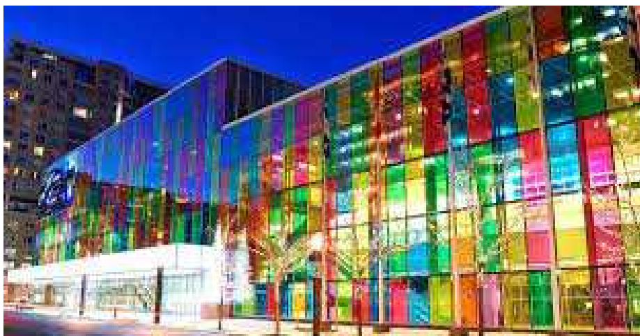
Fig. 5.8. Esempio di facciata di un edificio in vetro fotovoltaico trasparente colorato. (Fonte: https://www.progettazionecasa.com )
