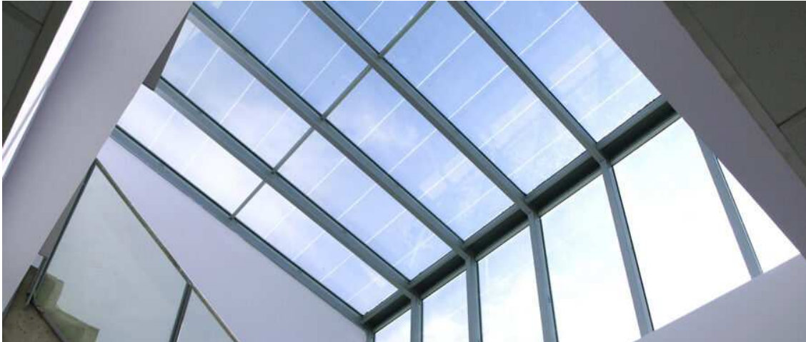
Fig. 5.2. Vetrata di moduli in vetro fotovoltaico trasparente. (Fonte: https://www.kerrspa.it )
