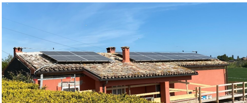
Figura 25, realizzazione dell'impianto fotovoltaico sul tetto dell'abitazione
