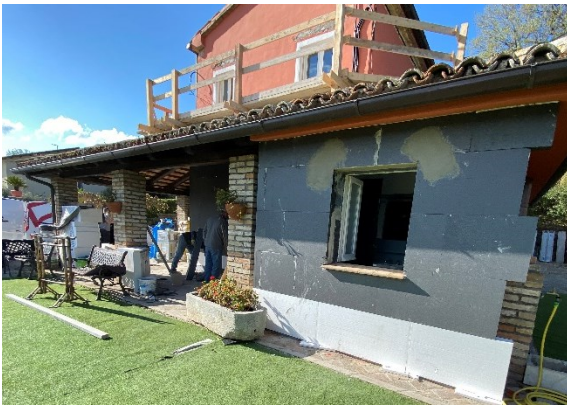
Figura 23, posa in opera del cappotto termico
