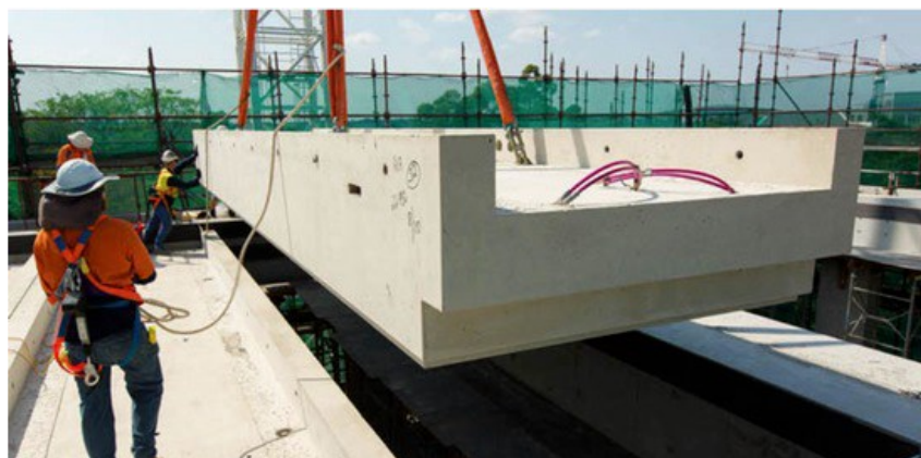
Fig. 11 - Travi prefabbricate impiegate nella realizzazione del GCI
