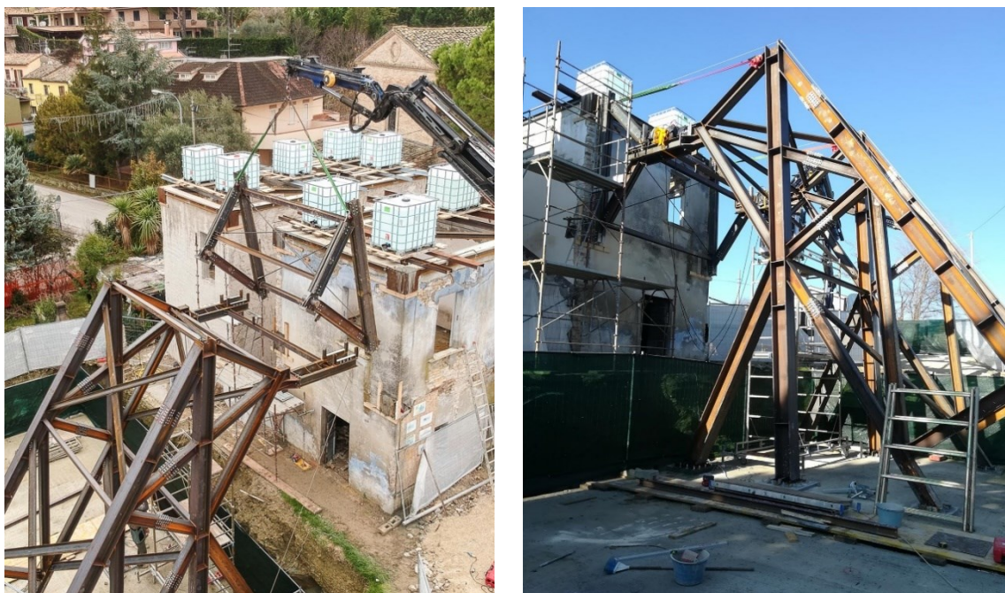
Fig. 14 - Prove di spinta sui due edifici oggetto di studio
