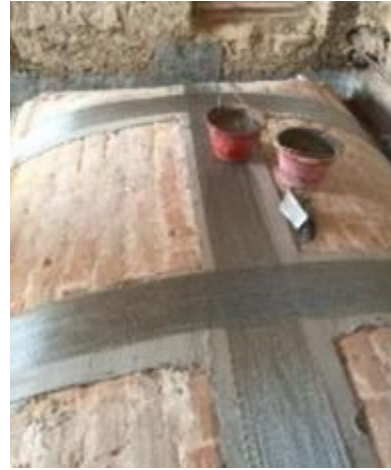
Fig. 12 - Rinforzo di pannelli murari con rete di basalto (a sinistra); Applicazione di fasce di tessuto metallico unidirezionale e malta per il rinforzo estradossale di volte murarie (a destra)
