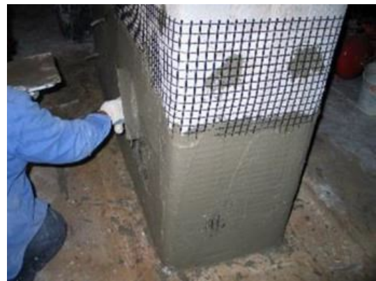
Fig. 13 - Cordolo sommitale realizzato con tessuti a base di reti di acciaio (a sinistra); Confinamento di pilastro in muratura con rete di vetro A.R. (a destra)
