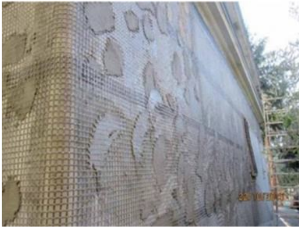
Fig. 12 - Rinforzo di pannelli murari con rete di basalto (a sinistra); Applicazione di fasce di tessuto metallico unidirezionale e malta per il rinforzo estradossale di volte murarie (a destra)
