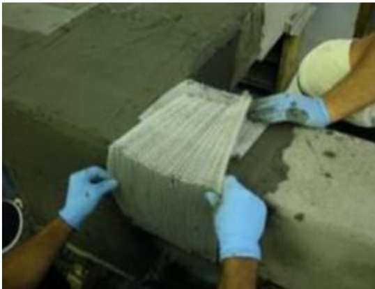
Fig. 16 - Rinforzo di nodi travi-pilastro con tessuto metallico unidirezionale e malta (a sinistra); Rinforzo antiribaltamento di pareti con rete di fibra di vetro, malta e fiocchi di fibra di vetro (a destra)
