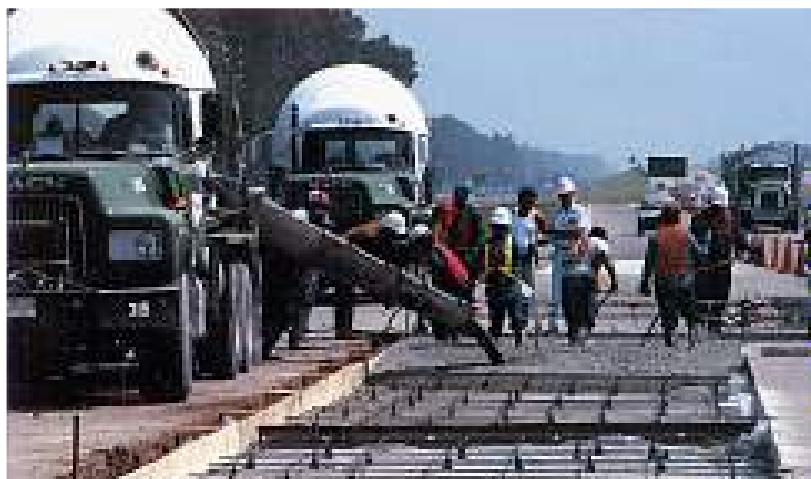
Fig. 8 - Lavori di riparazione di una strada con cemento Pyrament®
