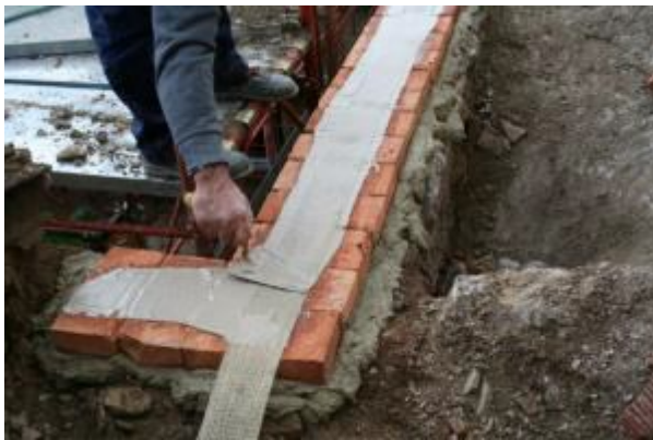
Fig. 13 - Cordolo sommitale realizzato con tessuti a base di reti di acciaio (a sinistra); Confinamento di pilastro in muratura con rete di vetro A.R. (a destra)
