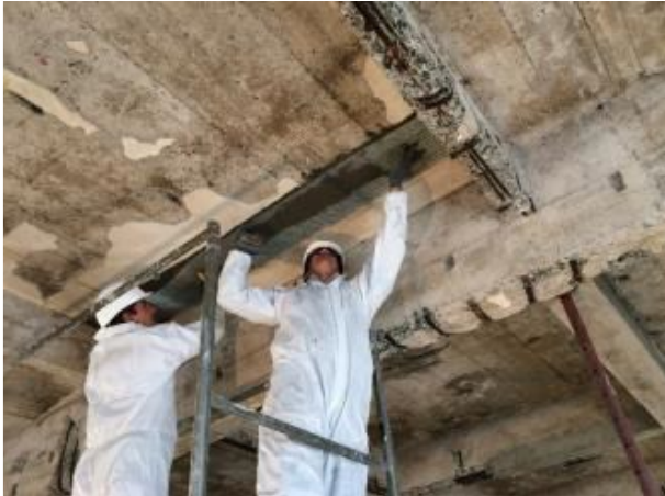
Fig. 15 - Rinforzo a flessione di trave mediante placcaggio con strisce di tessuto unidirezionale realizzate con rete di acciaio e malta cementizia (a sinistra); Confinamento di pilastro con tessuto metallico unidirezionale e malta (a destra)
