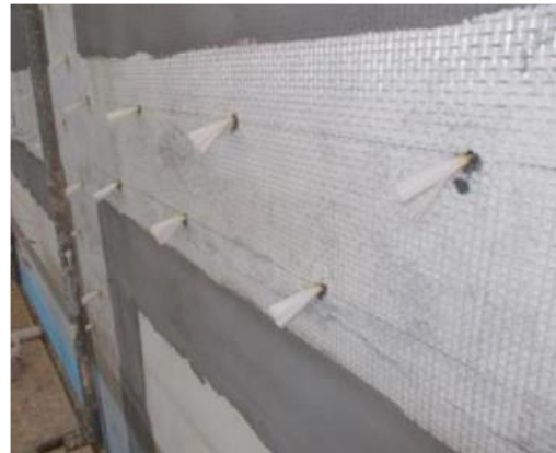
Fig. 16 - Rinforzo di nodi travi-pilastro con tessuto metallico unidirezionale e malta (a sinistra); Rinforzo antiribaltamento di pareti con rete di fibra di vetro, malta e fiocchi di fibra di vetro (a destra)
