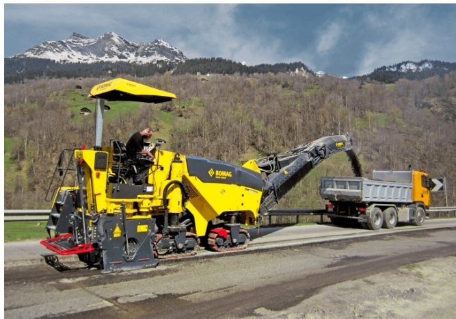
Figura 2.8 - Esecuzione di fresatura a freddo
