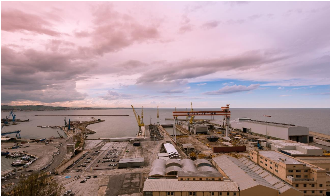
Figura 1.1 Il cantiere di Ancona
