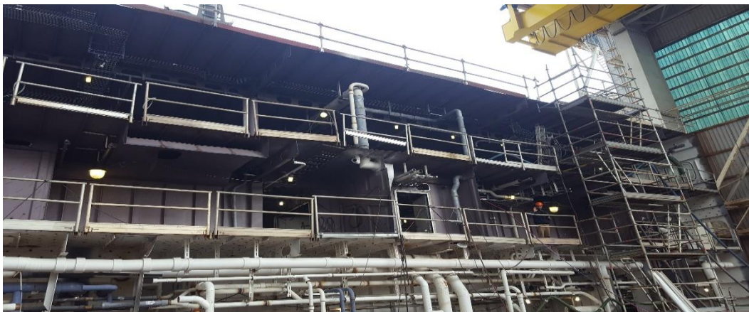
Figure 1.6 Lavorazione dei blocchi a terra
