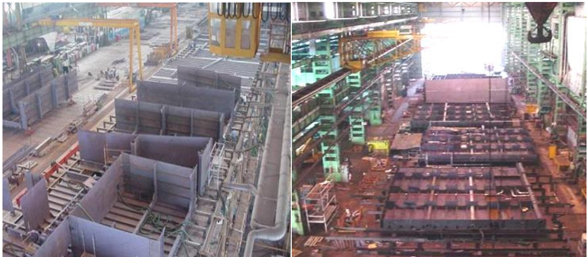
Figure 1.4-1.5 Assemblaggio delle lamiere e formazione delle sezioni
