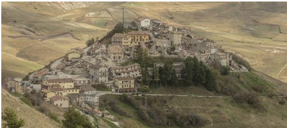
Figura 3.11 Danneggiamenti riscontrati post eventi sismici del 2016
