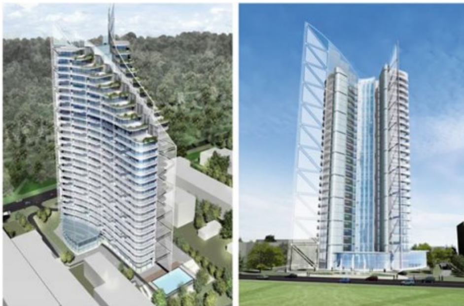
Figura 2.73 Progetto dell'hotel Hayat (Sea Plaza) con isolamento alla base, un edificio in cemento armato di 28 piani (con 2 piani interrati), alto 93.6m eretto a Sochi
