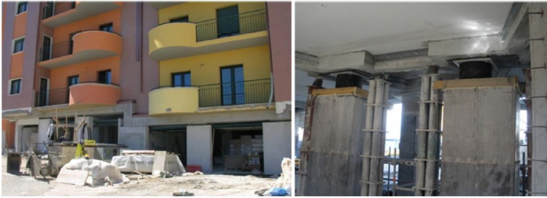
Figura 2.52 Edificio residenziale in Via Tigli a Pianola, L'Aquila
