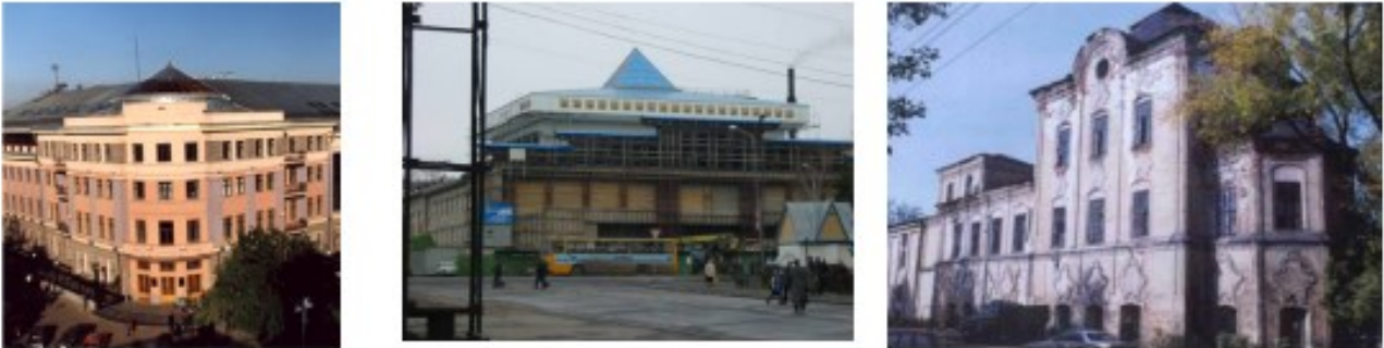
Figura 2.72 Da sinistra: Retrofit della banca Irkutsk City Central Bank con HDRB; al centro: retrofit del teatro Gorno-Altaysk con HDRB e dissipatori visco-elastici; a destra: retrofit della chiesa Mihailo-Arkhangelskaya a Irkutsk con HDRB
