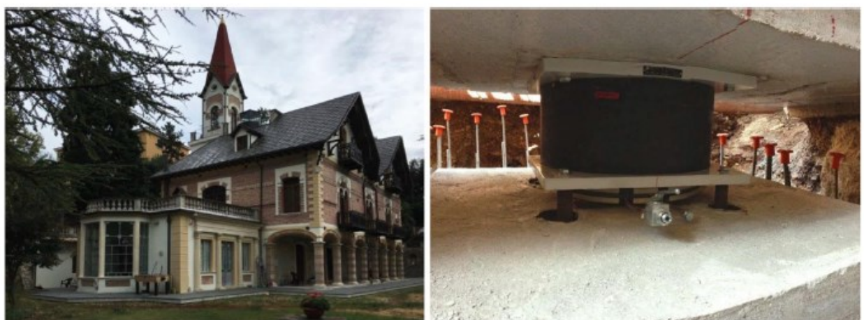
Figura 2.56 "La Silvestrella" a L'Aquila e vista sul sistema di isolamento
