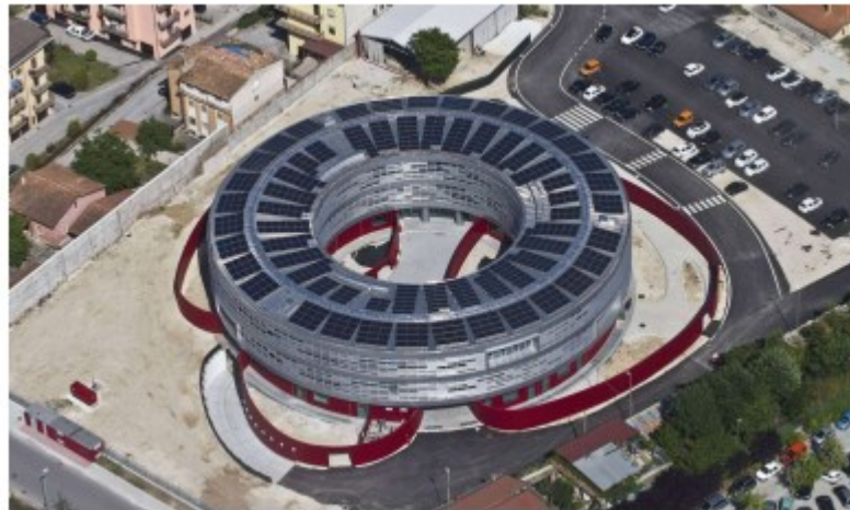
Figura 2.46 Edificio dell'ANAS a L'Aquila
