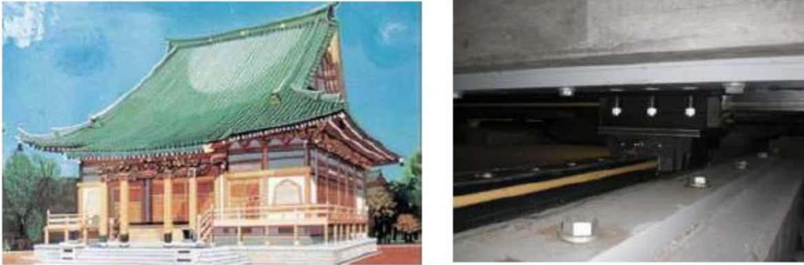
Figura 2.68 Tempio buddista di Jyorakuin, alcuni isolatori a ricircolo di sfere ed una coppia di isolatori elastomerici sovrapposti
