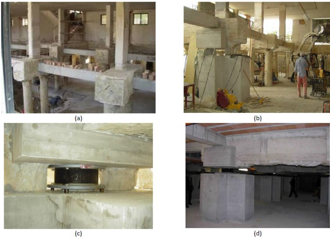
Figura 2.53 (a) fondazione prima dell'intervento; (b) nuova sottofondazione; (c) inserimento isolatore; (d) nuovo piano interrato
