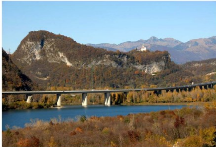
Figura 2.32 Il viadotto Somplago sismicamente isolato dopo il suo completamento
