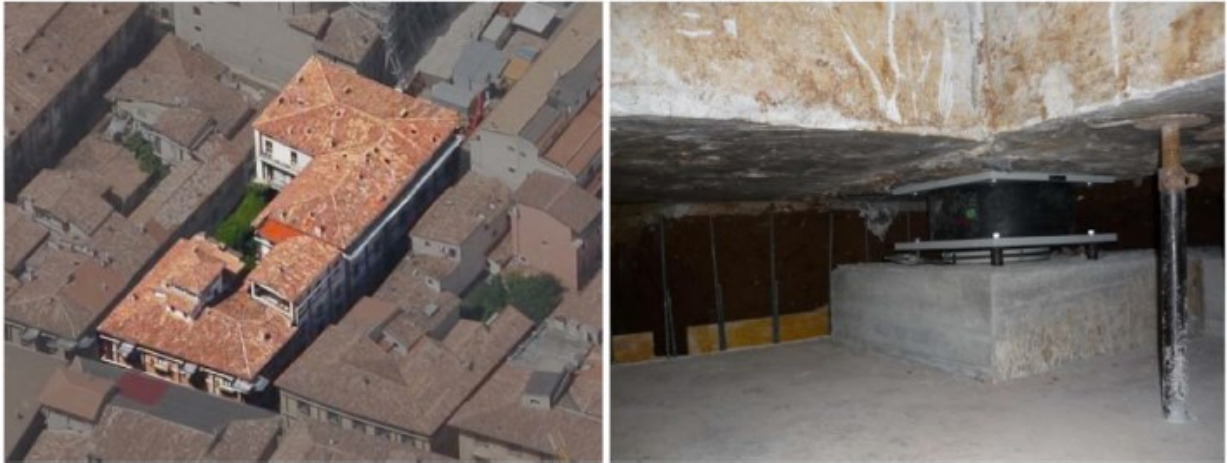
Figura 2.55 Palazzo Ciuffini-Cricchi-Volpi nel centro storico dell'Aquila e vista sul sistema di isolamento
