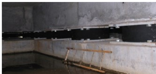
Figura 2.74 Alcuni dei 193 HDRB, prodotti in Italia, che proteggono l'edificio di figura 2.73
