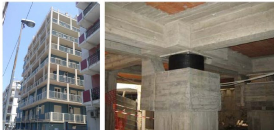
Figura 2.47 Edificio residenziale in via Spadafora a Messina e vista isolatore
