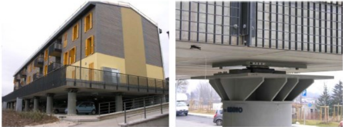
Figura 2.45 Uno degli edifici del progetto C.A.S.E. e vista di un isolatore
