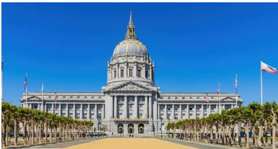
Figura 2.77 La City Hall di San Francisco (California, USA), distrutta dal sisma del 1906, ricostruita nel 1912, nuovamente danneggiata dal terremoto di Loma Prieta del 1989 e adeguata nel 2000 con 530 LRB e 62 SD
