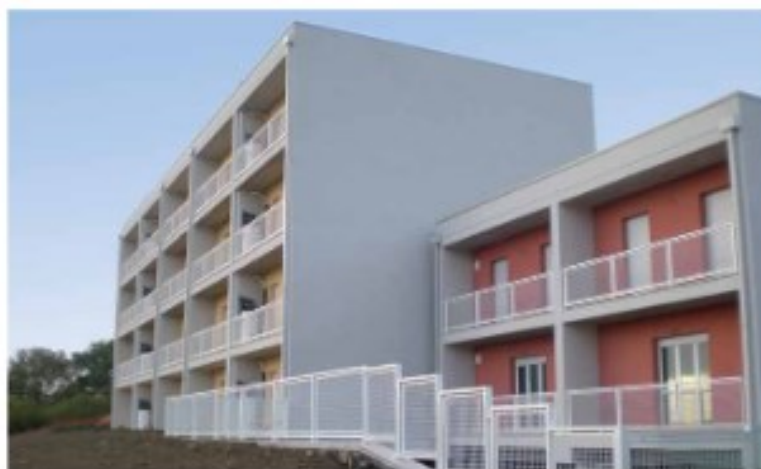
Figura 2.51 Edificio residenziale di Corciano isolato alla base
