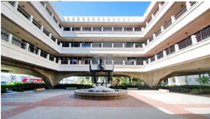
Figura 2.75 Adeguamento dell'edificio comunale di Glendale (2008), costituito da una struttura in acciaio rivestita in calcestruzzo e sostenuta solamente attraverso 4 isolatori FPS
