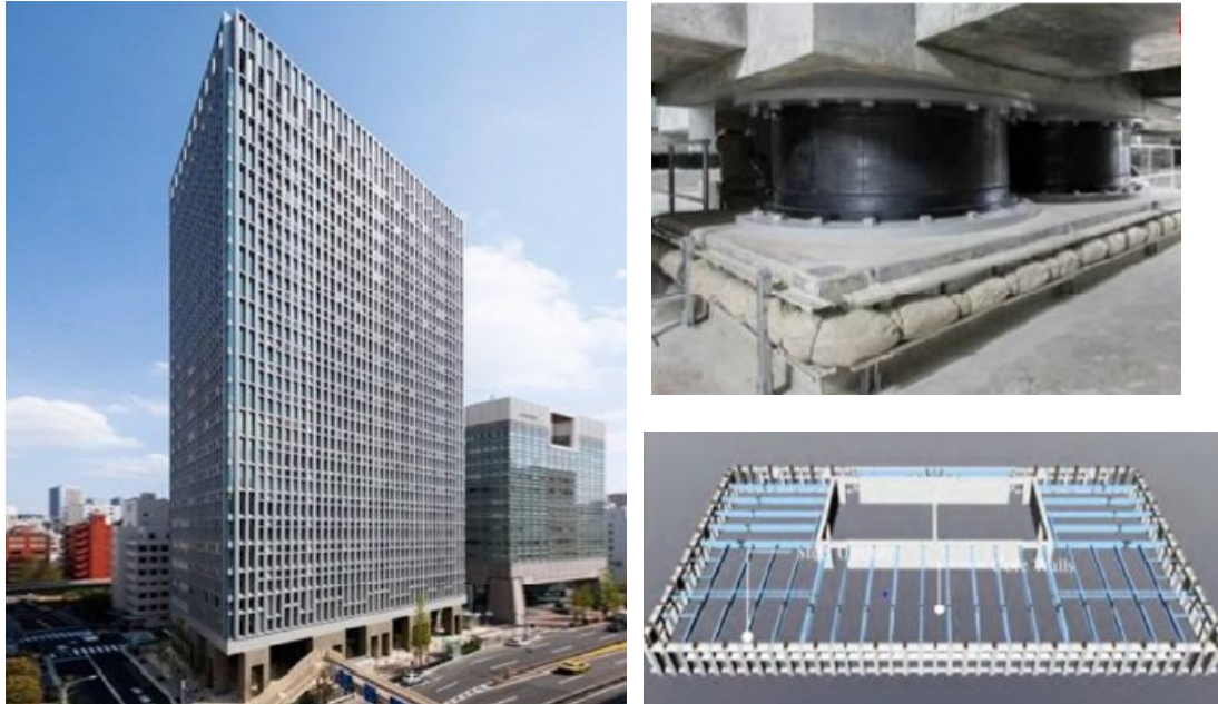
Figura 2.66 Vista esterna del Shimizu Corporation Tokyo Headquarters e dettaglio sistema di isolamento
