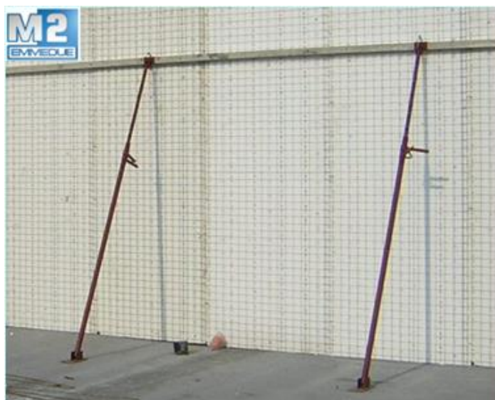
Figura 11 - Disposizione dei puntelli diagonali per la posa in opera dei pannelli
