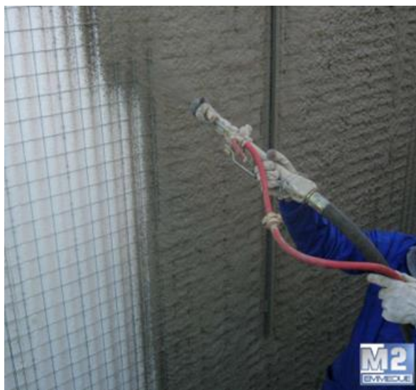
Figura 13 - Getto di completamento dello spritz beton
