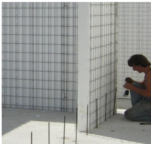
Figura 10 - Ancoraggio alla fondazione
