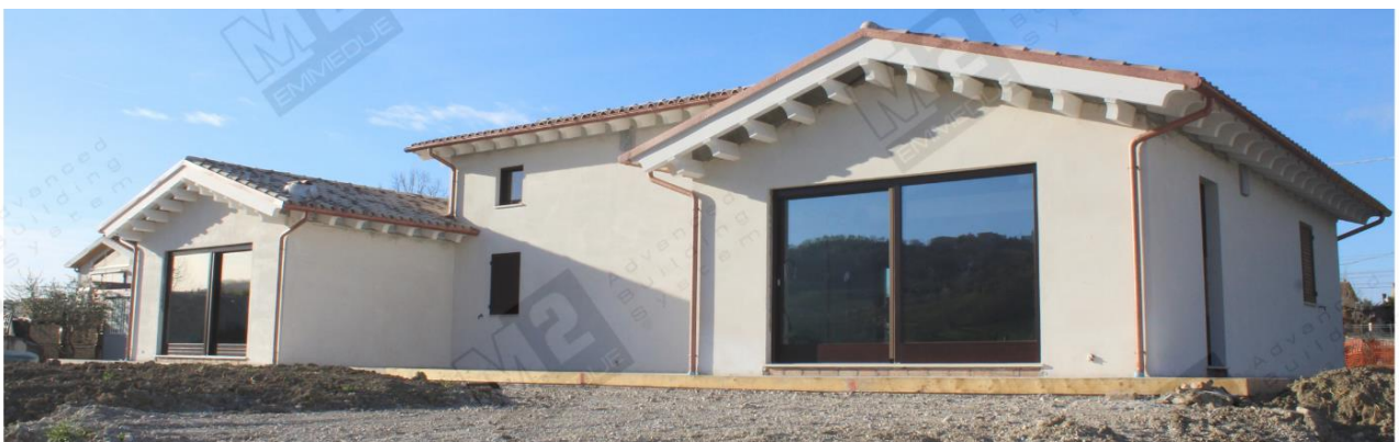
Figura 7 - Esempio di un'abitazione realizzata con pannelli sandwich
