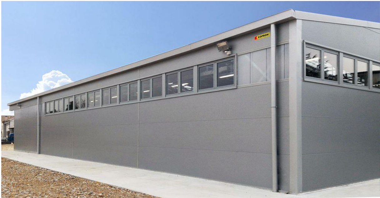
Figura 3 - Capannone realizzato con pannelli sandwich
