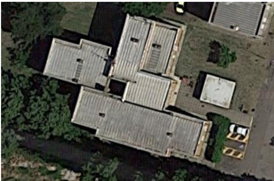
Figura 3 - Vista aerea edificio "caso studio" n. 2
