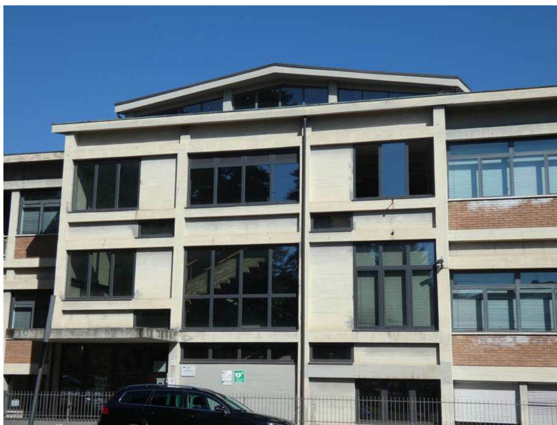
Fotografia del prospetto frontale del Corpo L
