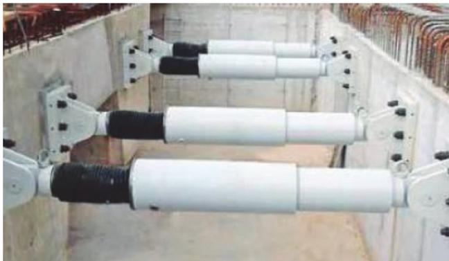
Figura 3.2. Dissipatori viscosi del tipo cilindro-pistone.
