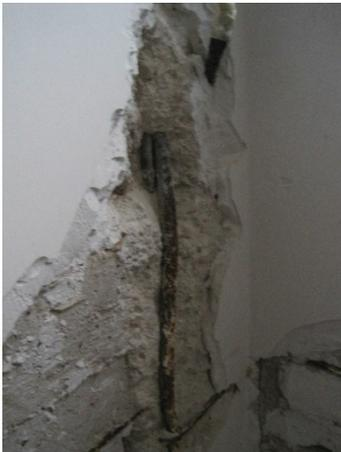
Figura 4.12. Particolare dell'armatura liscia dei pilastri.
