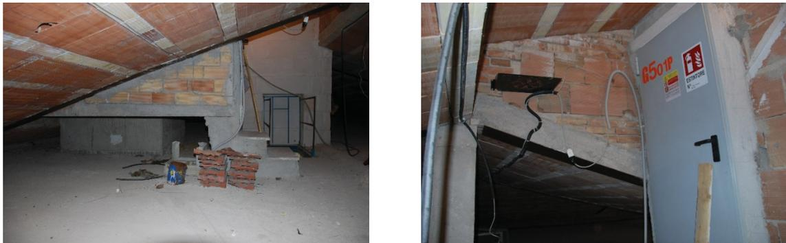
Figura 4.23. Foto in cui si nota l'extra-corsa del nucleo ascensore, la soletta di 20 cm aggettante dal nucleo stesso e le tamponature del torrino.
