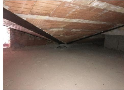
Figura 4.17. Particolari del solaio di copertura e dell'impalcato del sottotetto in cui sono presenti travi REP estradossate.
