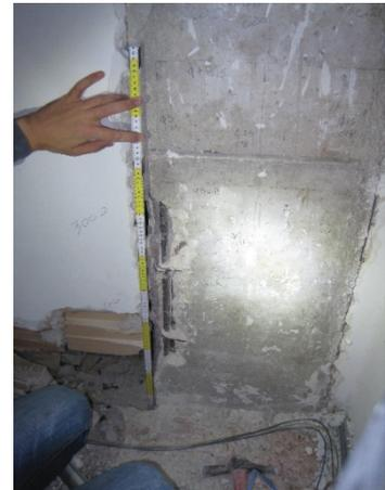
Figura 4.13. Particolare della lunghezza di sovrapposizione delle barre longitudinali dei pilastri.
