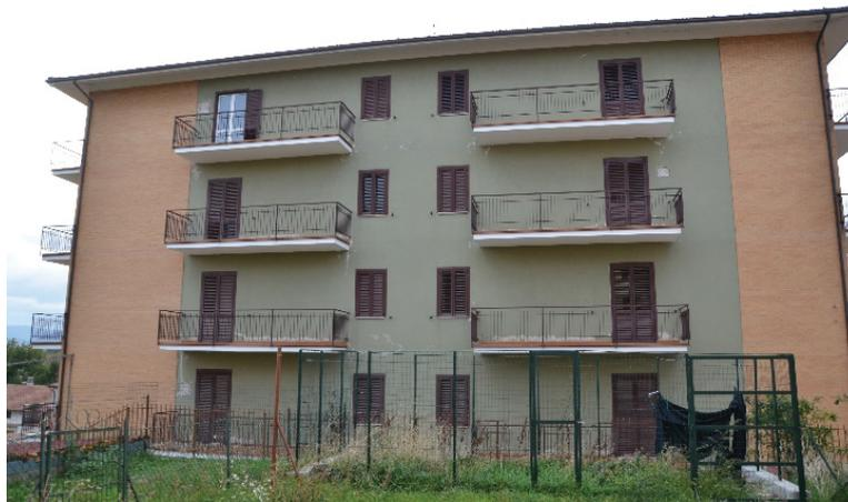
Figura 4.34. Tamponature esterne di due tipologie: intonacate e faccia a vista.
