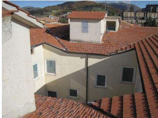
Figura 4.22. Copertura a padiglione con torrini per l'extra-corsa dei nuclei ascensori.
