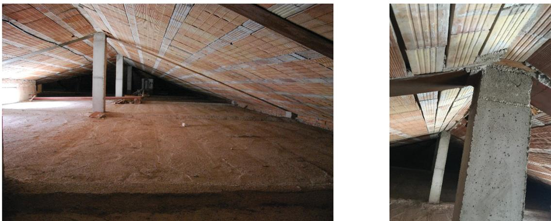
Figura 4.31. A sinistra si notano le travi REP che appoggiano sui pilastri di sezione quadrata da 25 cm x 25 cm, mentre a destra un particolare della trave di colmo.
