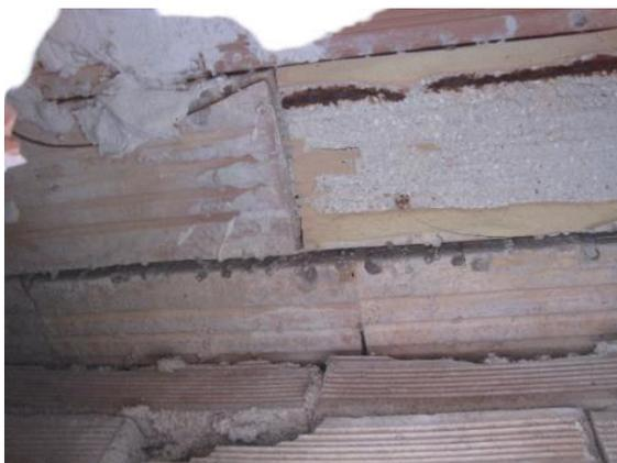
Figura 4.15. Trave perimetrale, vista da sotto, composta da due travetti di solaio affiancati tra loro.
