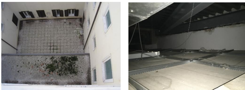
Figura 4.33. Cortile interno con relativa porzione ricoperta da solaio misto acciaio-calcestruzzo.
