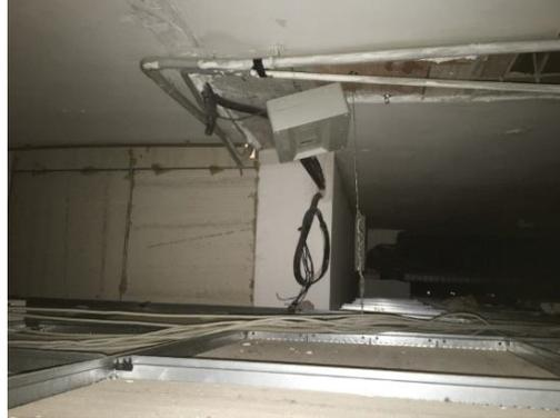
Figura 4.29. A sinistra il tavellone costituente il controsoffitto del portico, mentre a destra il controsoffitto con pannelli fonoassorbenti.
