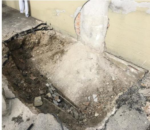
Figura 4.24. Scavo eseguito in corrispondenza di un plinto perimetrale.
