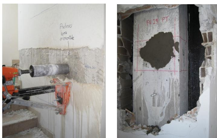
Figura 4.40. Modalità di estrazione della carota cilindrica a sinistra, mentre a destra chiusura del foro con malta cementizia antiritiro.
