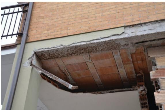
Figura 4.25. Particolare dell'orditura del solaio che scarica sulla trave REP.
