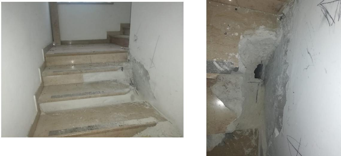
Figura 4.21. Particolare dell'assenza di collegamento tra scala e nucleo ascensore.
