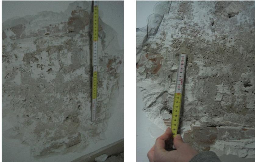
Figura 4.20. Particolare dell'appoggio della soletta rampante della scala sulle tamponature perimetrali.
