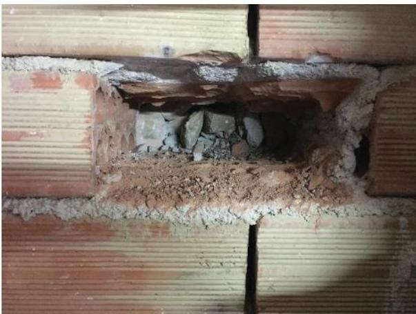
Figura 4.18. Muro contro terra con blocchi a 8 fori circolari.
