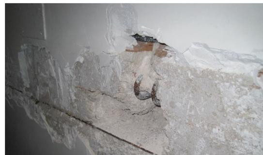
Figura 4.14. Foto di alcune travi REP in cui è possibile osservare: il fondello in acciaio, il traliccio di collegamento tra corrente inferiore e superiore ed inoltre anche dei ganci molto probabilmente di compartecipazione trave-soletta del solaio.
