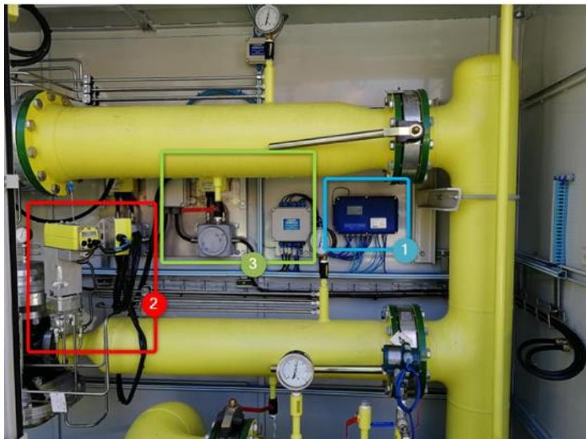
Figura 23: Componenti del GOLEM: 1. GOLIAH2P; 2. Motore ; 3. Controlli e connessioni [11]
