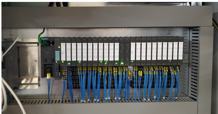
Figura 5: ET 200SP con schede di I/O
