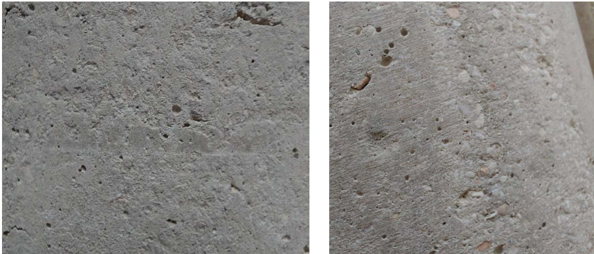
Immagine 27 – Differenza tra la superficie dei cilindri in calcestruzzo prima (sx) e dopo (dx) la rimozione dello strato polveroso
