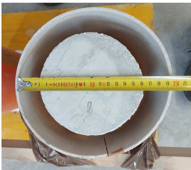
Immagine 15 – Cilindro in calcestruzzo pronto a ricevere il getto di rinforzo, da notare la centratura rispetto al cassero esterno
