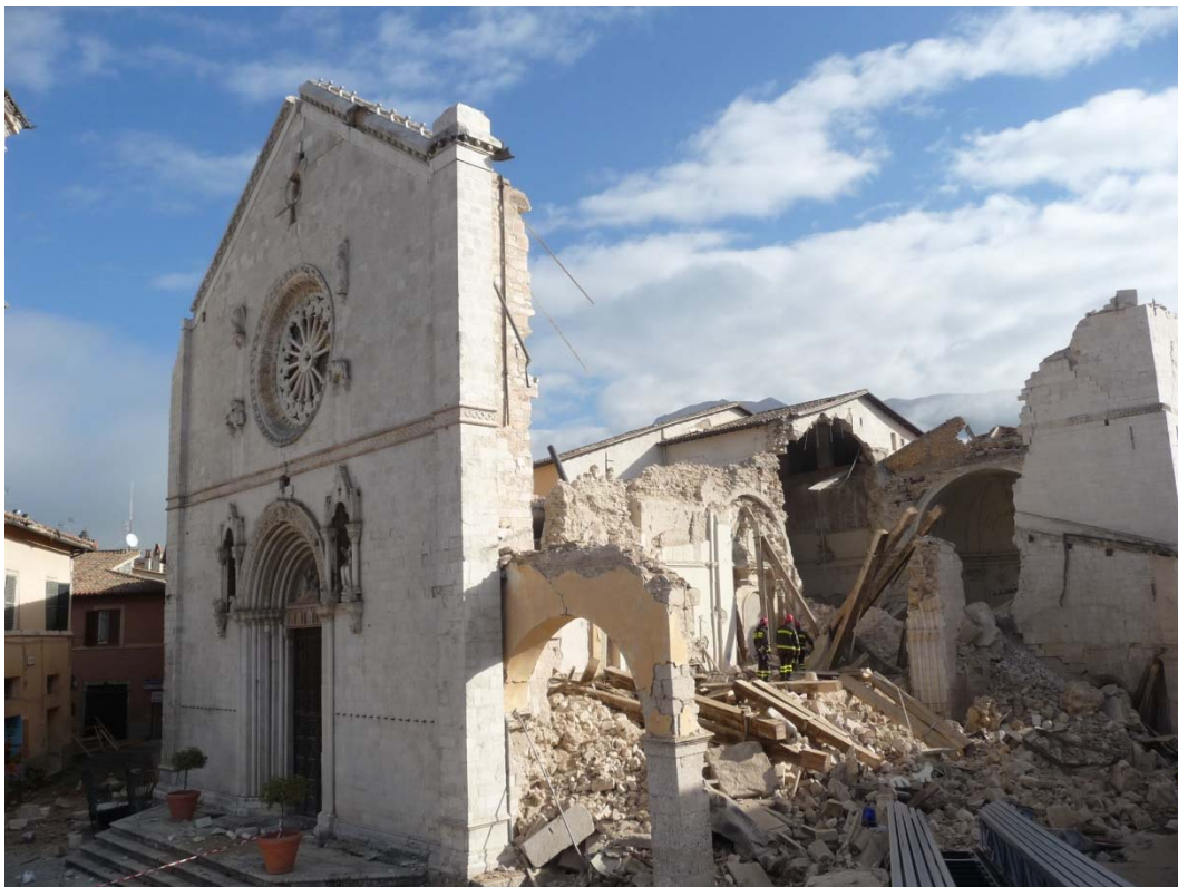
Basilica di San Benedetto a Norcia a seguito del sisma 2016, Fonte: www.sisma2016.gov.it
