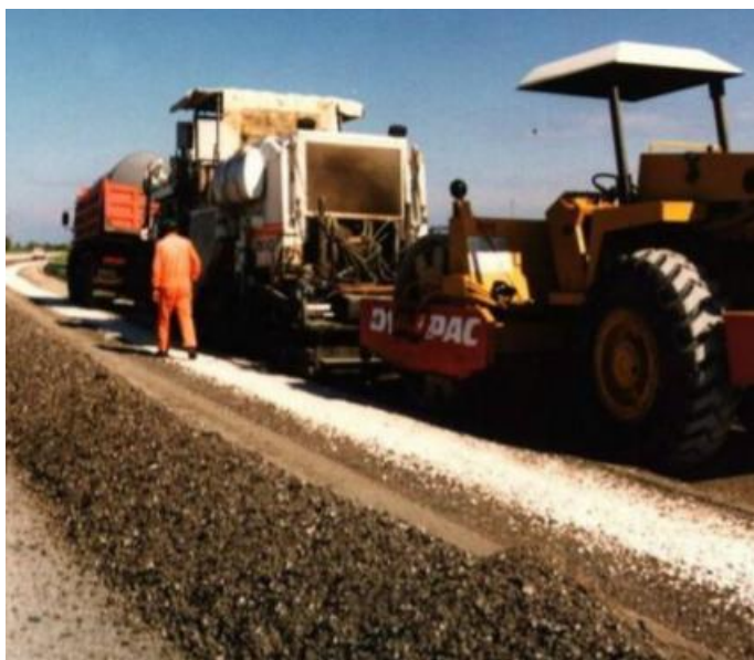
Figura 1.1.1.2 Stesa di aggregati di aggiunta
