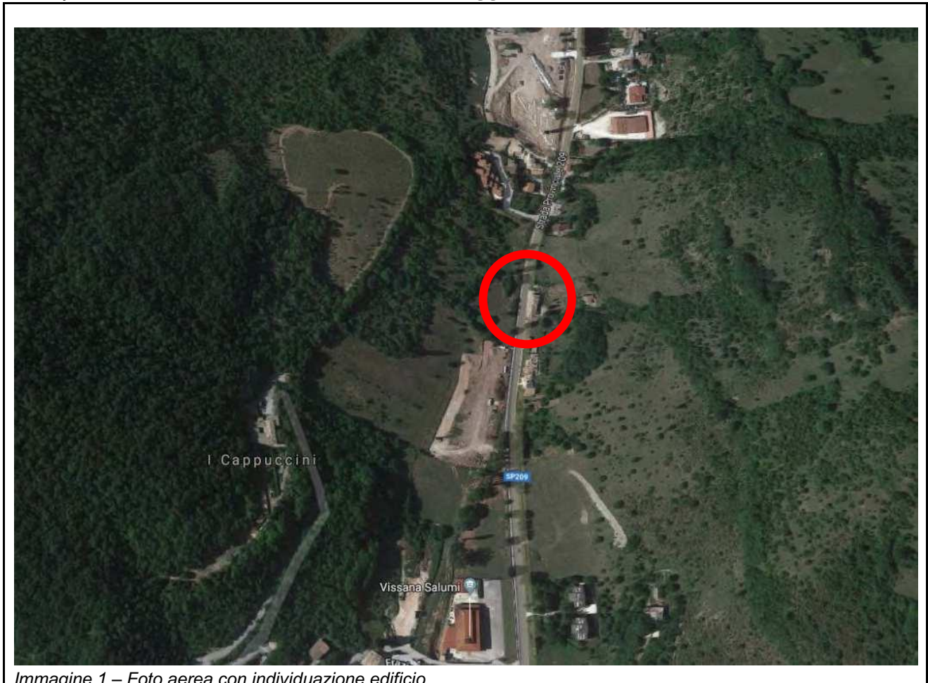
Immagine 1 – Foto aerea con individuazione edificio
