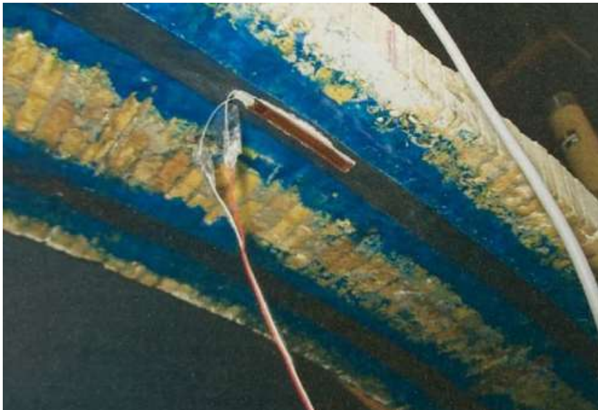
Figura 3.7 Arco rinforzato con estensimetro applicato alla fibra
