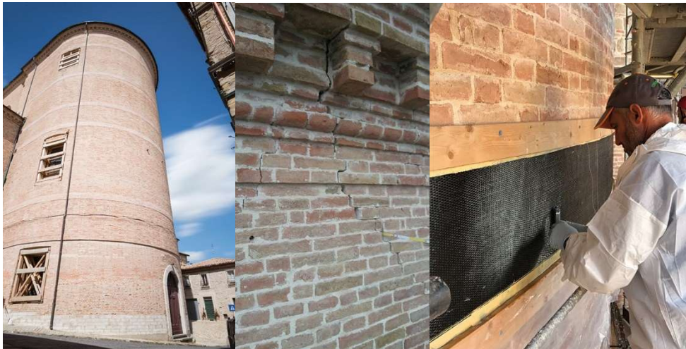
Figura 2.12 Cerchiatura con FRP dell'abside lesionata
