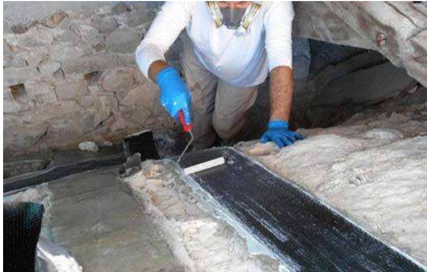
Figura 2.9 Applicazione tessuti di fibra di carbonio con resina epossidica
