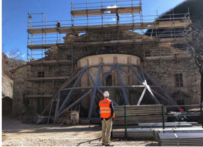
Figura 2.16 Puntellamento dell'abside per la cerchiatura con una fascia di FRP
