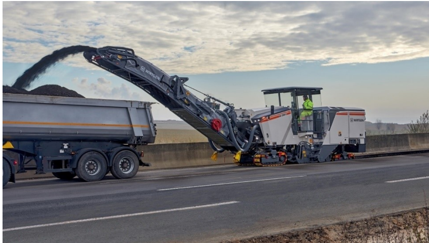
Figura 2.4 - Fresatura a freddo
