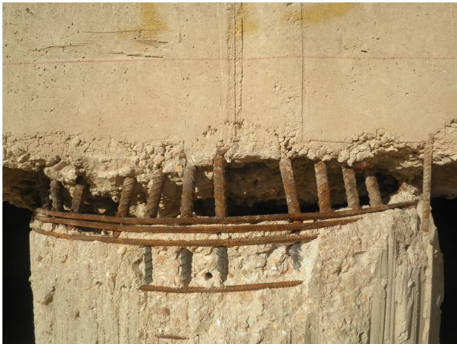
Figura 4.2. Particolare dei ferri piegati connessine palo - trave
