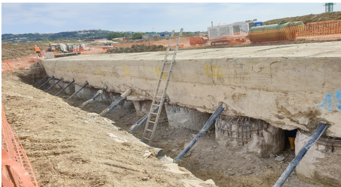
Figura 5.2.4. Scavo lato monte terminato
