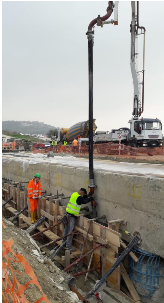
Figura 5.7.2. Getto di calcestruzzo
