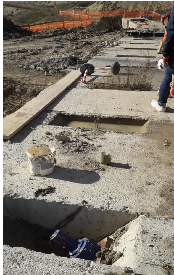
Figura 5.4.3. Cavità piene di acqua e terra
