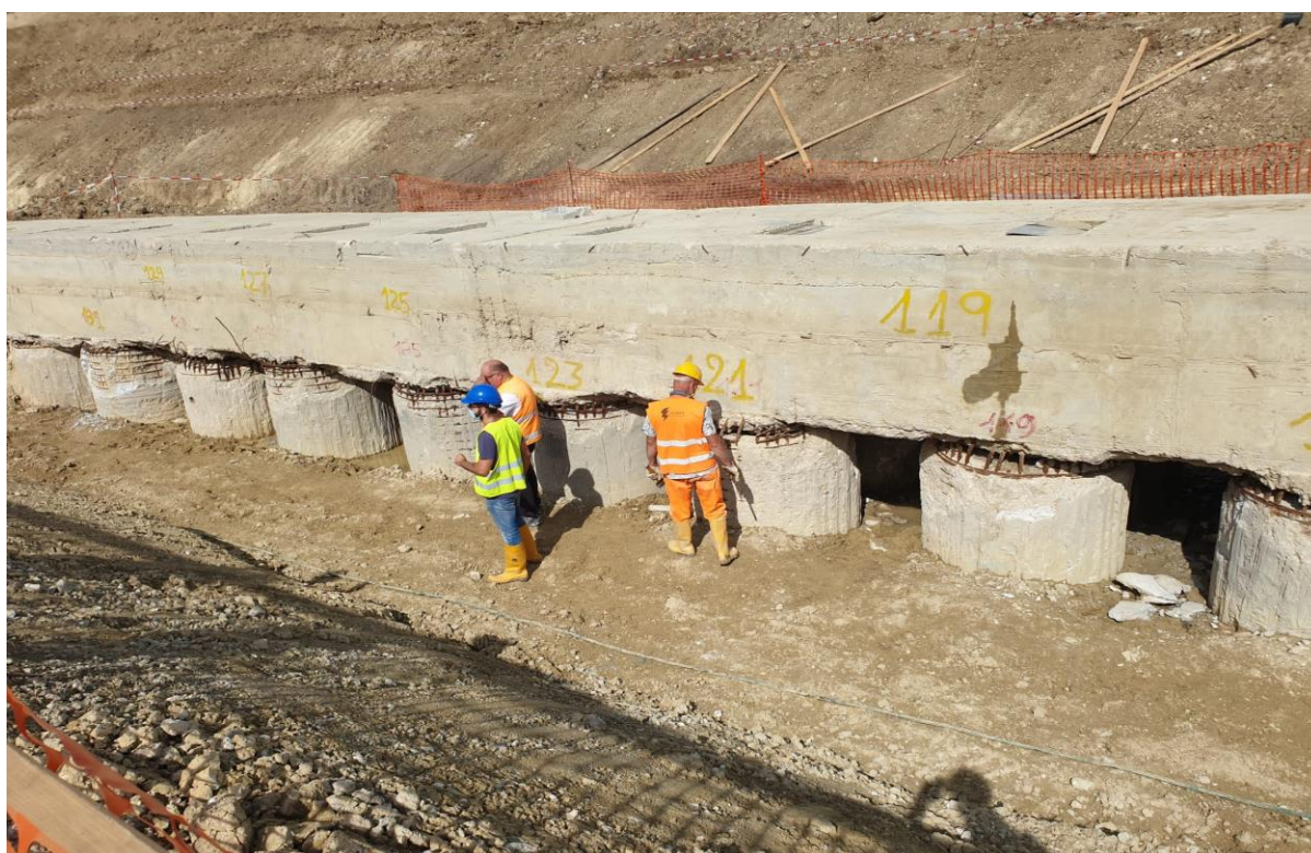
Figura 5.2.5. Scavo lato valle terminato
