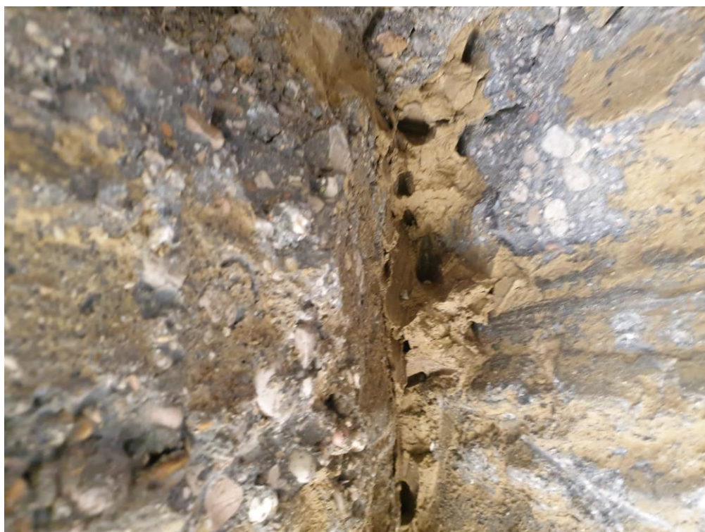
Figura 4.3 Inclusioni terrose nella connessione palo-trave
