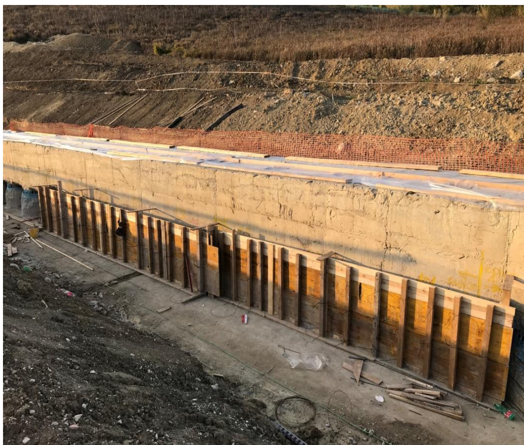
Figura 5.7.1. Posizionamento casseri
