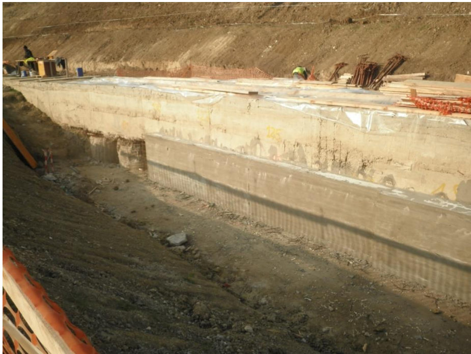
Figura 5.7.3. Parete terminata di calcestruzzo
