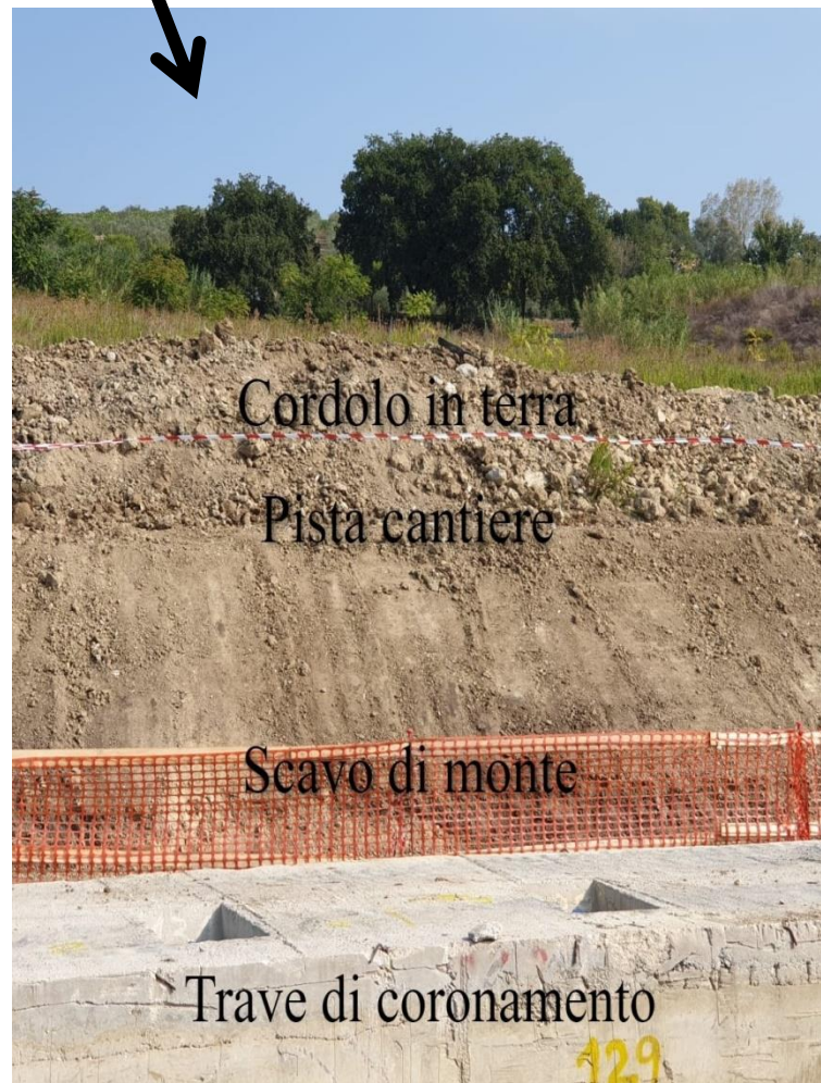
Figura 5.1.2. Particolare dello scavo e cordolo in terra
