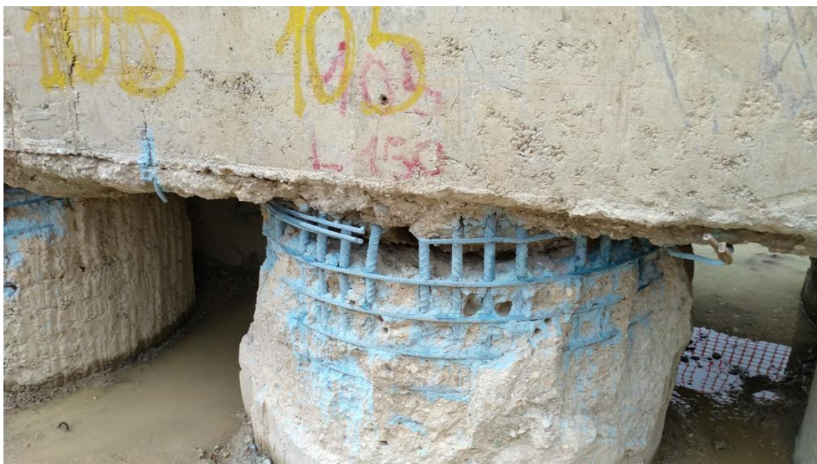
Figura 5.5.1. Passivazione dei ferri d'armatura scoperti
