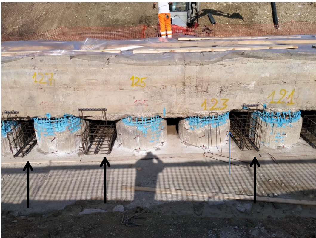
Figura 5.5.1. Armatura aggiuntiva all'interno dell'intercapedine palo-palo
