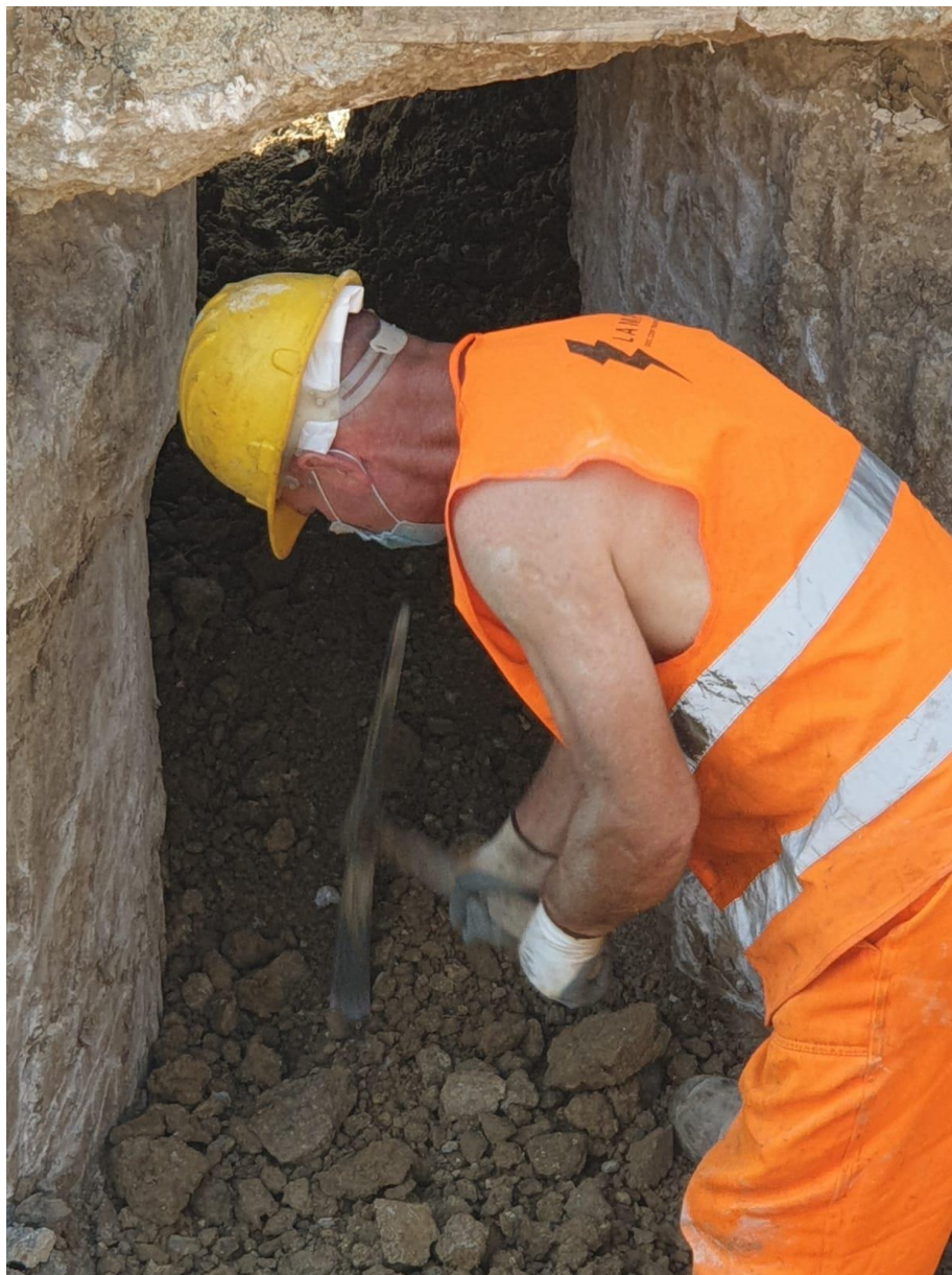
Figura 5.2.3. Scavo lato monte con mezzi manuali
