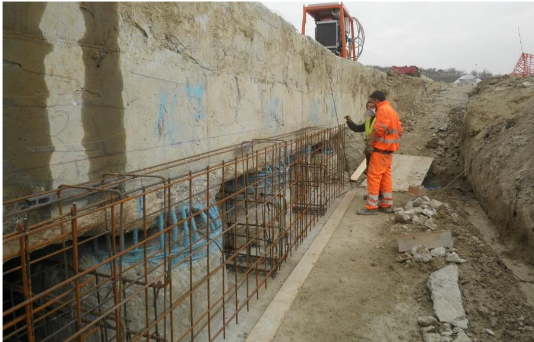
Figura 5.5.1. Armatura aggiuntiva della parete di calcestruzzo e relativa posa in opera della rete elettrosaldata
