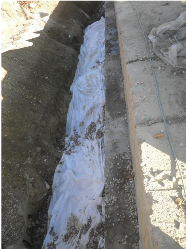
Figura 5.9.2. Inserimento geotessuto
