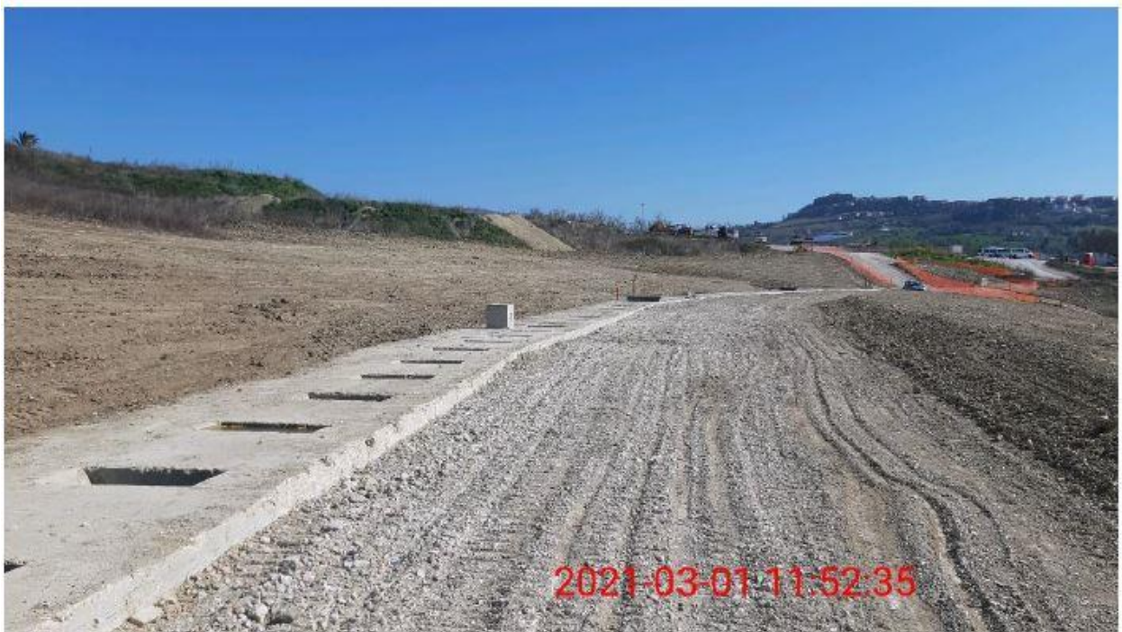
Figura 5.9.3. Opere di ripristino terminate
