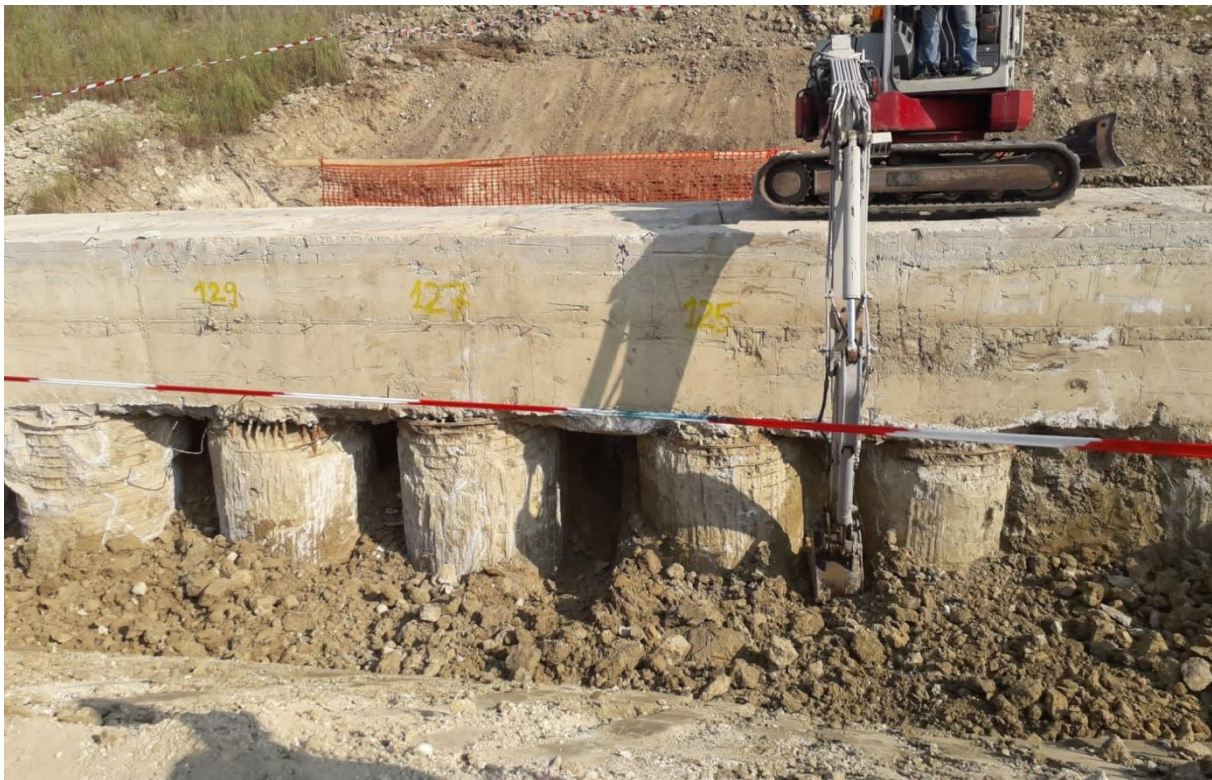
Figura 5.2.2. Scavo lato valle con mezzo meccanico
