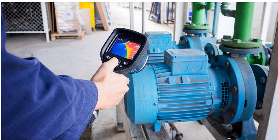
Figura 3.1: Misura di temperatura tramite termocamera
