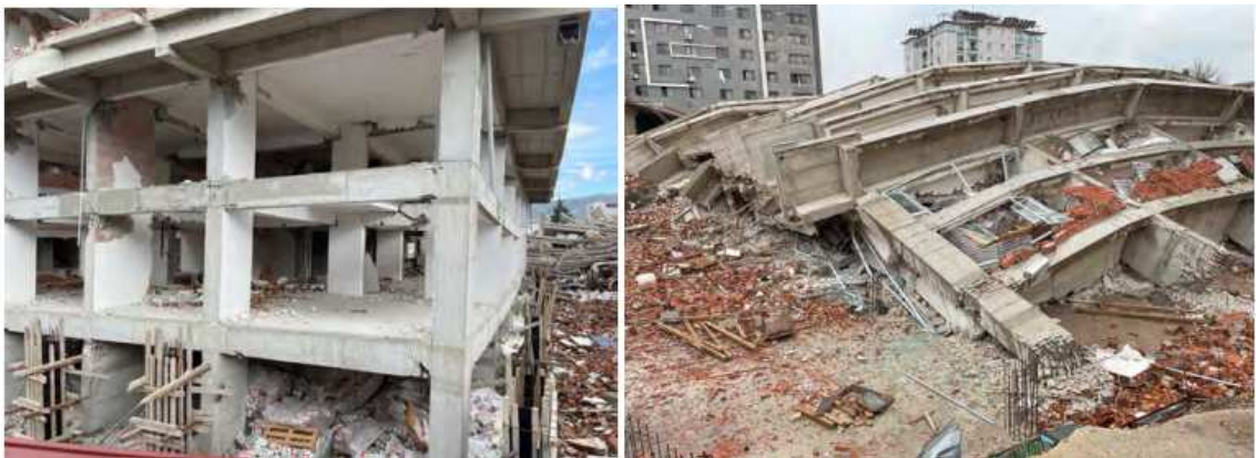
Fig. 2.15_ Edificio in costruzione con sistema a telaio in cemento armato, Antakya.
