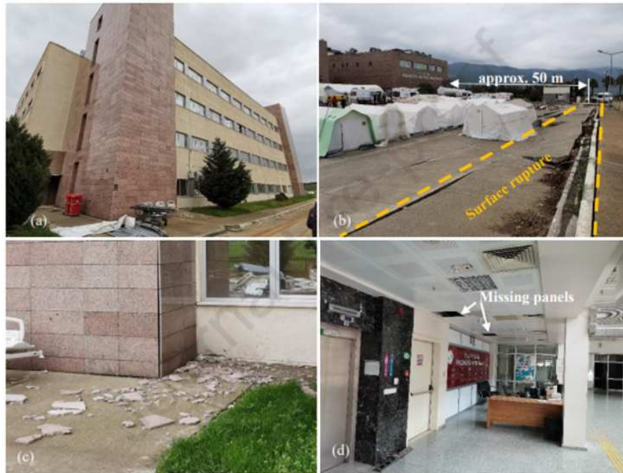
Fig. 2.30_Vista posteriore di F3, Ospedale statale di Islahiye e i relativi danni non strutturali
