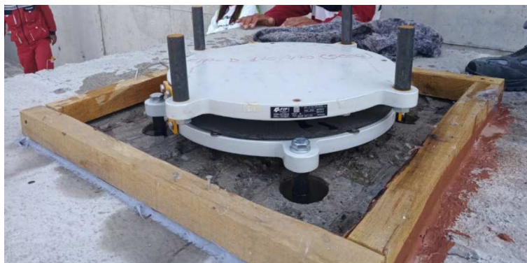
Fig. 4.2_ Isolatore a doppia superficie di scorrimento utilizzato nell'edificio preso in esame
