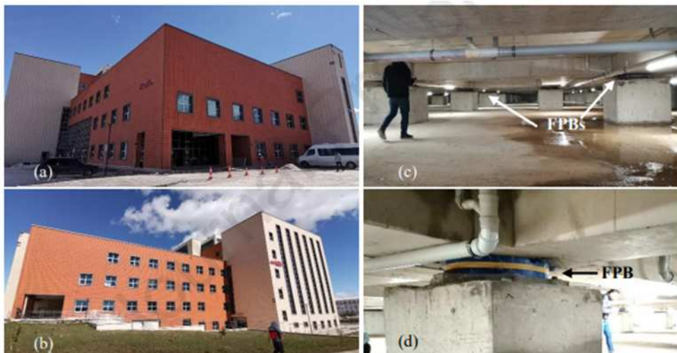
Fig. 2.46 Edificio B3 dell'ospedale statale di Doğanşehir isolato: (a) vista frontale, (b) vista posteriore, (c) seminterrato che ospita il piano di isolamento e (d) e isolatore ad attrito nel piano di isolamento.
