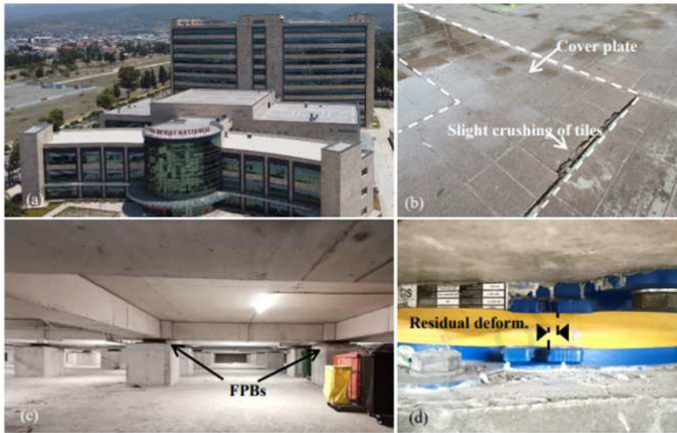
Fig. 2.51_L'edificio isolato B5 dell'ospedale statale di Dörtyol
