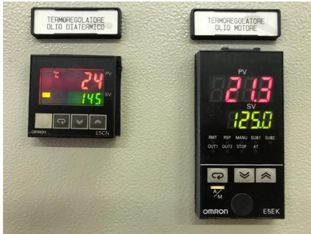
FIG. 7: PID DI CONTROLLO TEMPERATURA DI OLIO DIATERMICO (a sinistra) ED OLIO MOTORE (a destra)
