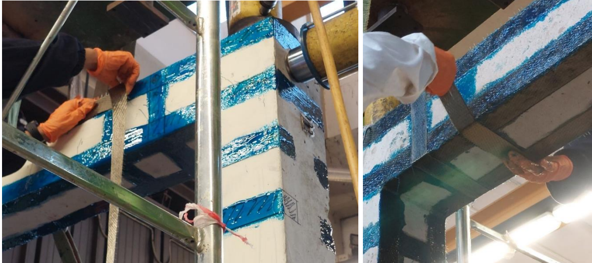
Figure 3.8, 3.9 - APPLICAZIONE RINFORZO
