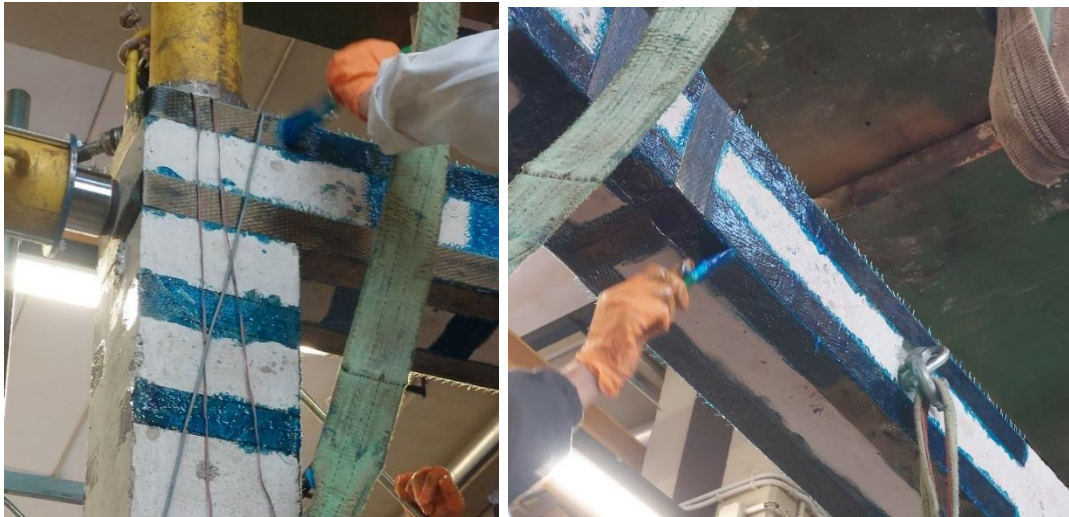
Figure 3.11, 3.12 - APPLICAZIONE SECONDA MANO DI RESINA
