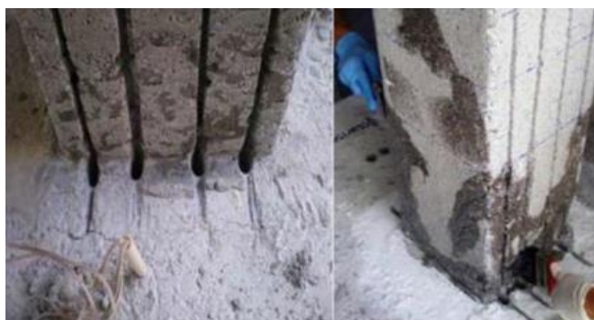
Figure 1.2 - RINFORZO FRP CON TECNICA NSM
