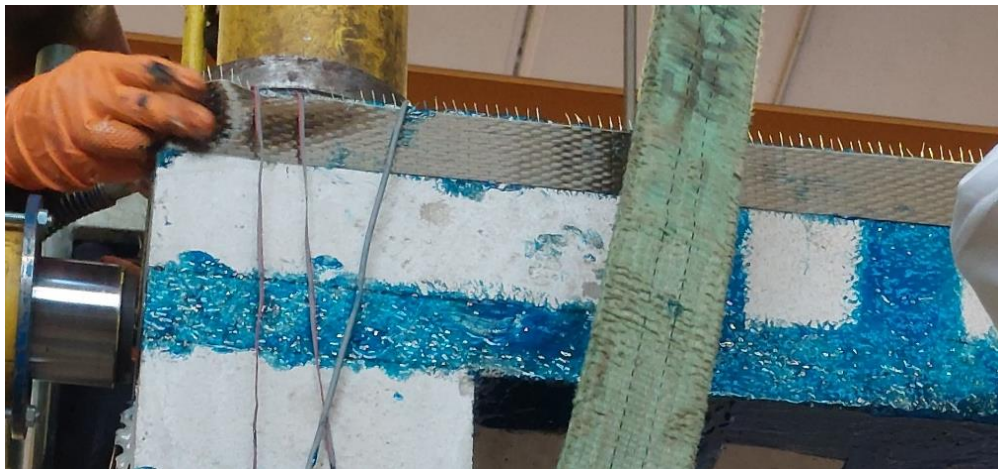
Figure 3.10 - APPLICAZIONE RINFORZO NEL NODO
