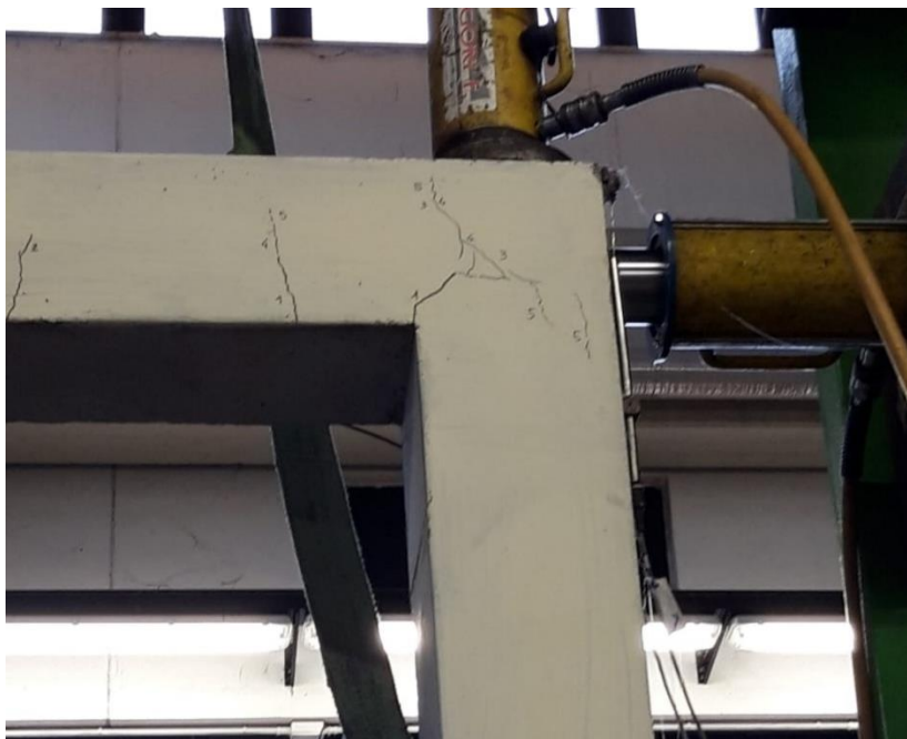
Figure 1.1 - TIPICA FESSURAZIONE DI UN NODO TRAVE-PILASTRO
