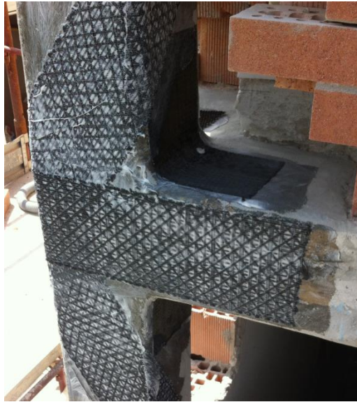
Figure 1.3 - PLACCAGGIO CON FRP
