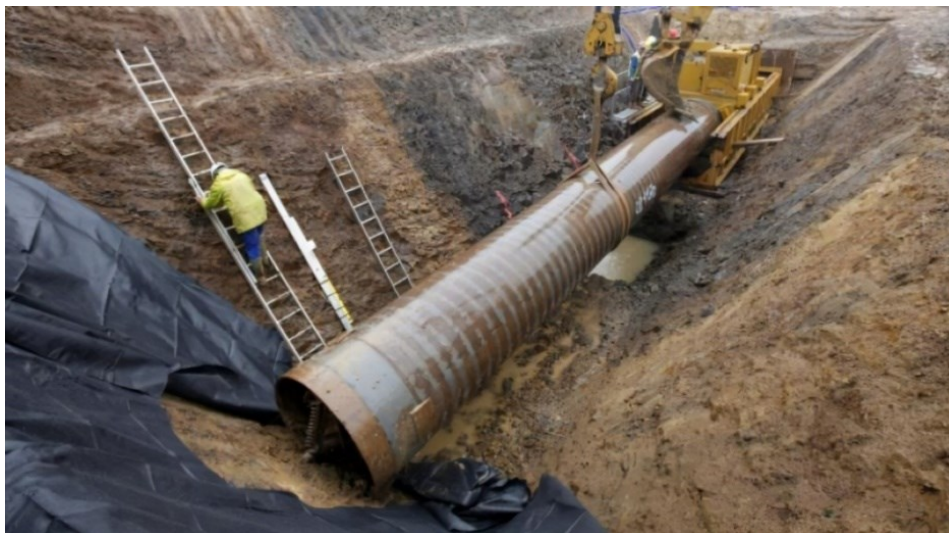
Figura 1-3: Posa di metanodotto in trincea (Ojinaga, 2014)
