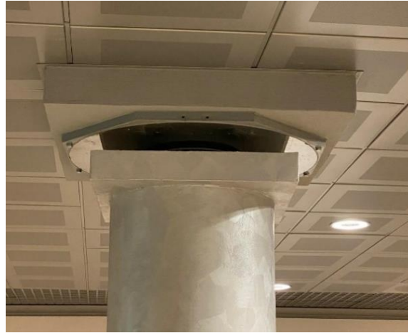
Figura 3.3: Isolamento in testa al pilastro
