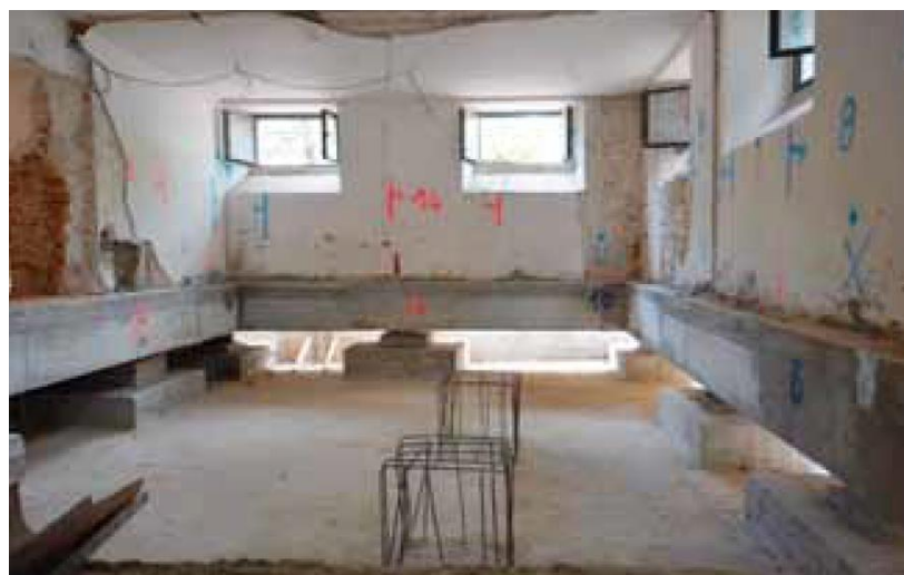
Figura 3.12: Cordolo di fondazione e sistema di isolamento ultimato
