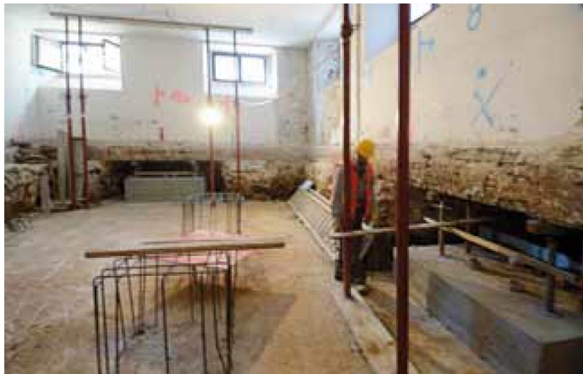
Figura 3.11: Realizzazione baggioli per inserimento degli isolatori
