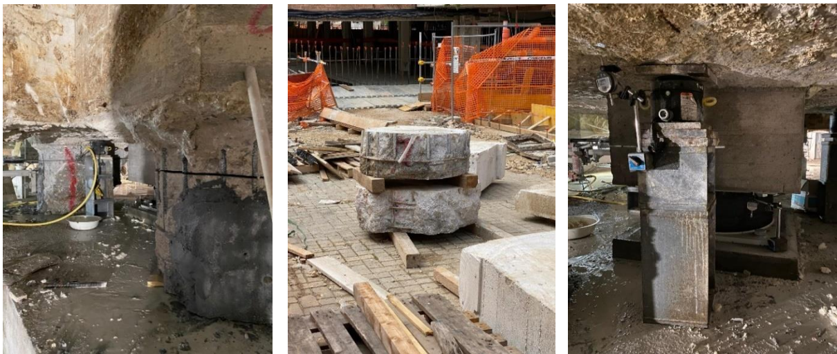
Figura 3.6: Processo di posizionamento in testa ai pali di fondazione del sistema di isolamento
