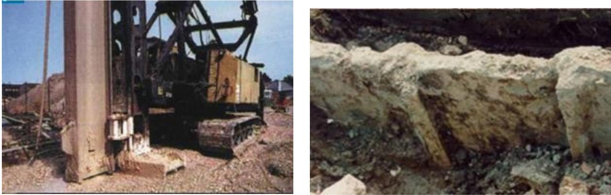
*Fig. 2.6 – Perforazione ed attrezzatura per diaframmi sottili e foto di una porzione di diaframma.*
