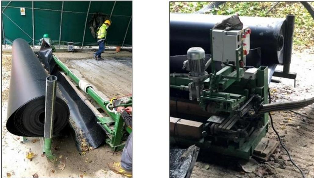
*Fig. 3.31 – Telo in HDPE pronto per l'operazione di saldatura dei giunti (sinistra); macchinario che permette la saldatura del giunto sul telo in HDPE (destra).*
