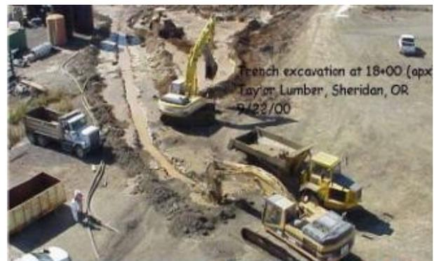
*Fig. 2.10 – Realizzazione di un diaframma terreno-bentonite.*
