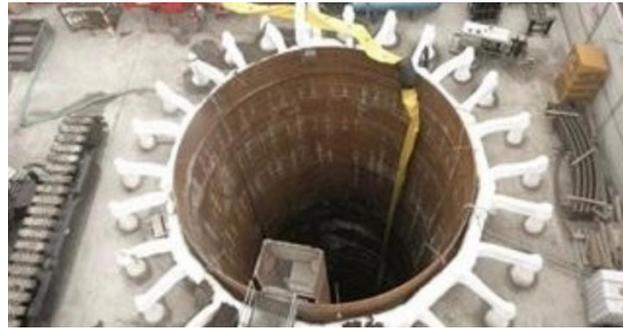
*Fig. 2.7 – Tecnica del congelamento del suolo.*
