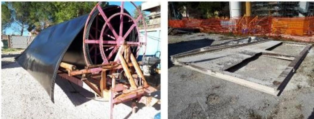
*Fig. 3.7 - - Telo in HDPE per la realizzazione di un diaframma composito con giunto a pettine all'estremità del telo (sinistra); telaio in acciaio per il collocamento del telo nello scavo, per tutta la profondità del diaframma (destra).*
