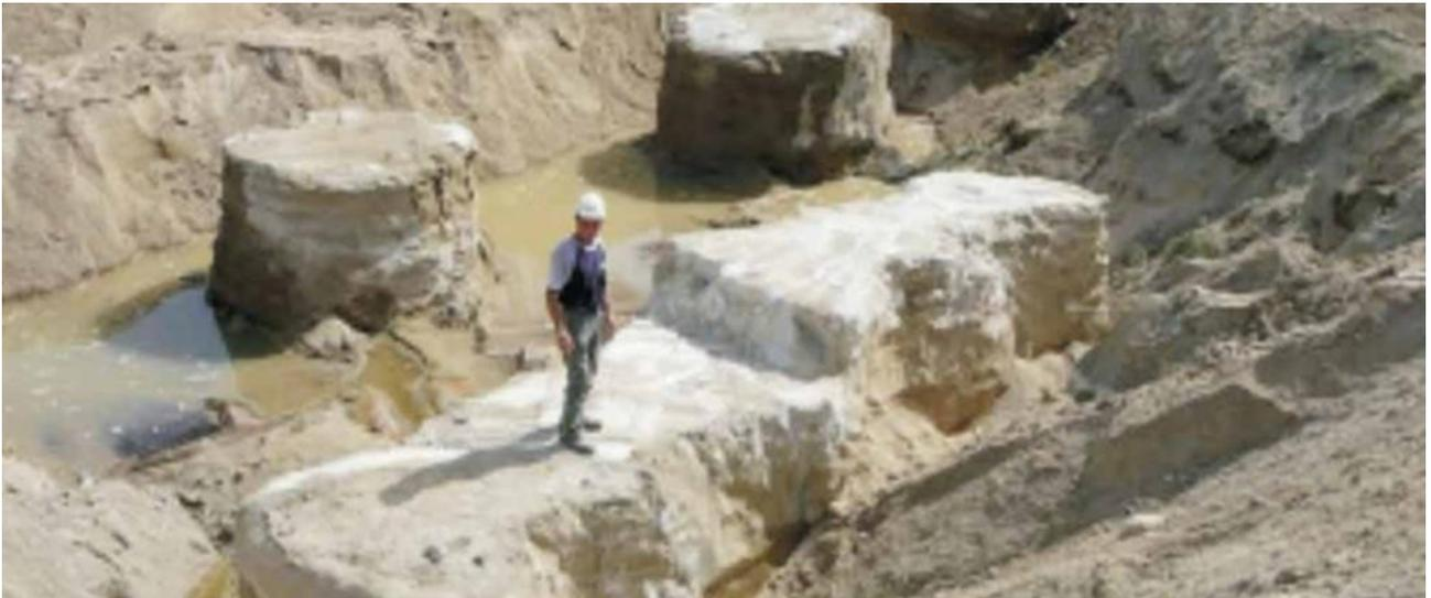
*Fig. 2.8 – Trattamento con jet-grouting colonnare e nella versione “Candy jet”
