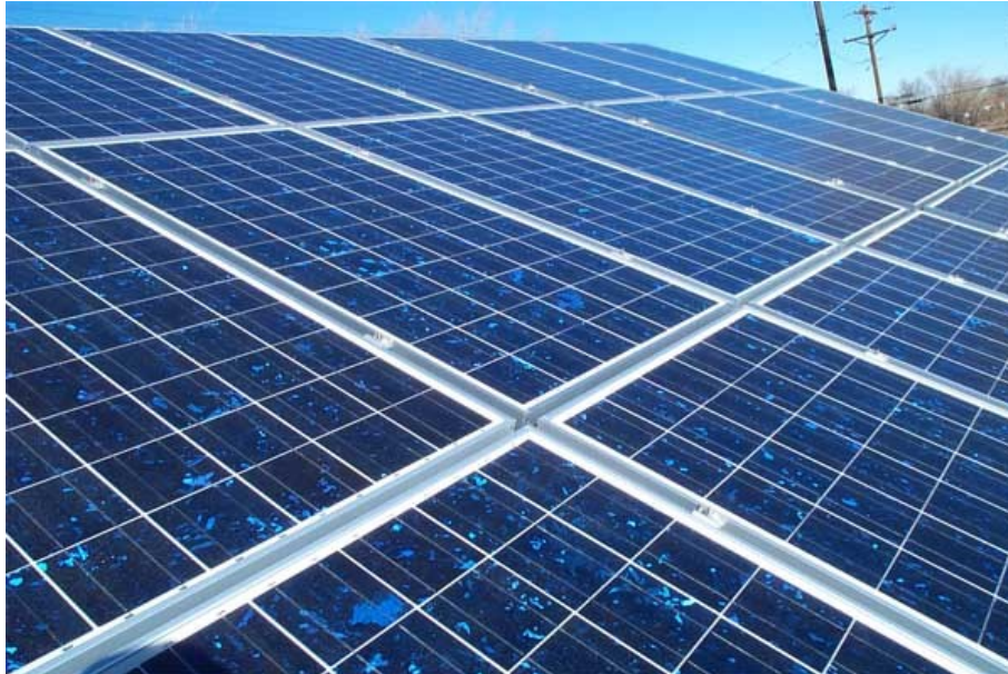
Fig. 7 - Celle fotovoltaiche policristalline [16]
