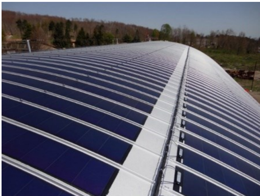
Fig. 8 - Celle fotovoltaiche amorfo o a film sottile [17]
