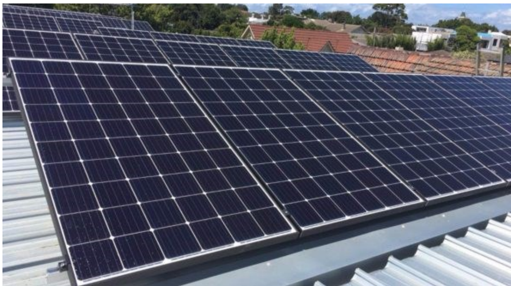
Fig. 6 - Celle fotovoltaiche monocristalline [15]
