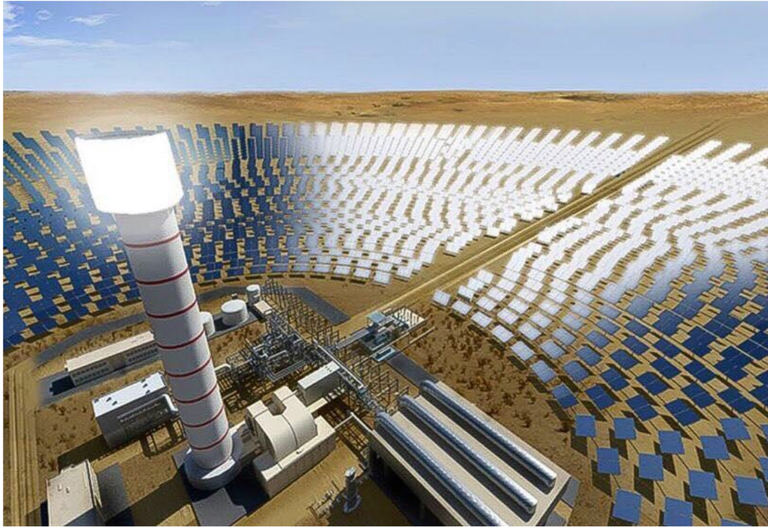
Fig. 12 - Esempio di CSP a torre centrale [23]
