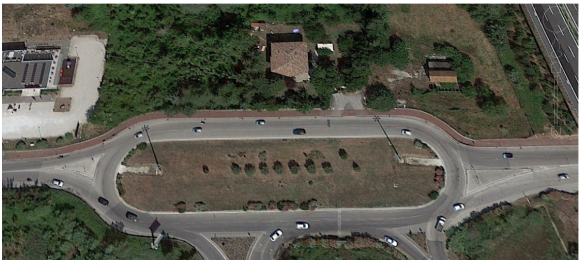
Figura 31. L'immagine rappresenta la vista dall'alto del filare alberato presente in rotatoria, si nota come i due lecci, alle estremità, siano maggiormente distanziati.
