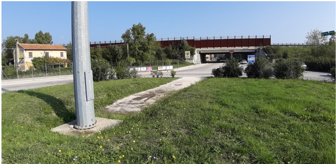
Figura 26. Le due fotografie mostrano la vegetazione arbustiva posizionata alle curve della rotatoria- Vista da rotatoria.
