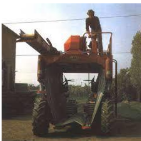
Figura 1: Vendemmiatrice a scuotimento verticale semovente realizzata in Italia dalla ditta MTB nel 1969
