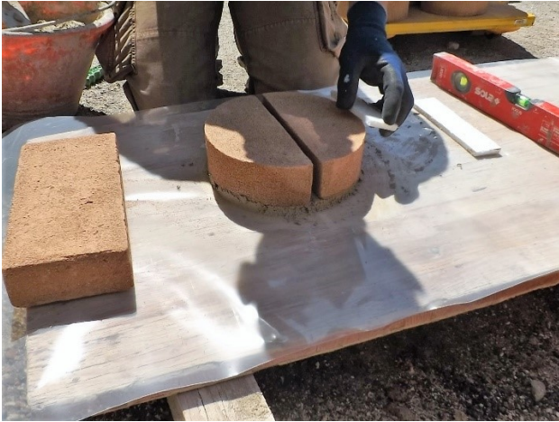
Figura 3.39 Posa strato di allettamento e dei primi due mattoni.
