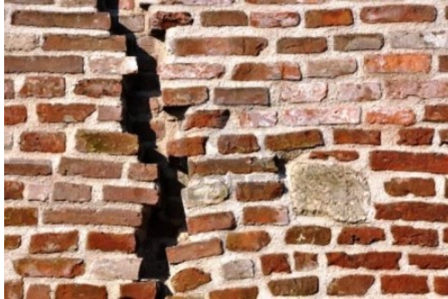
Figura 2.4 Classica rottura a compressione 1 .
