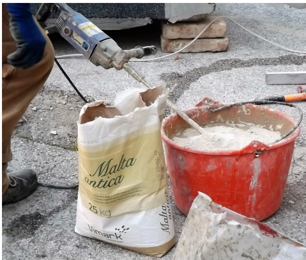
Figura 3.4 Preparazione della malta con mixer meccanico.
