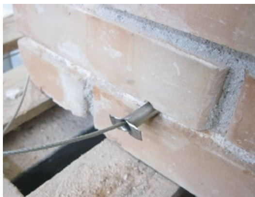
Figura 2.31 Inserimento del cavo in acciaio per il foro trasversale [38].
