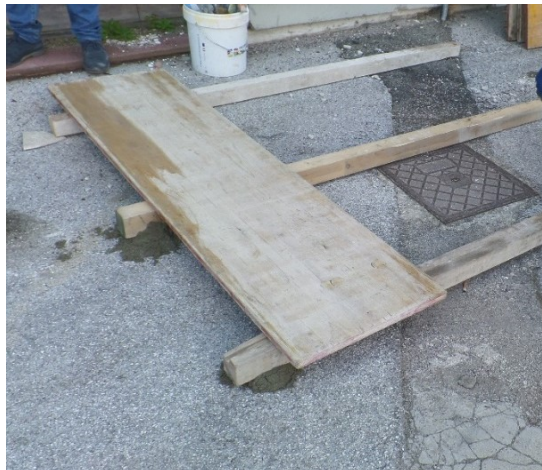
Figura 3.36 Messa a livello tavole in legno.
