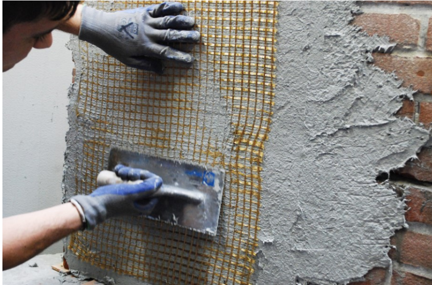
Figura 2.17 Metodo di posa del sistema FRCM 3
