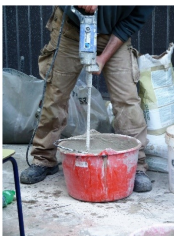
Figura 3.38 Preparazione della malta.
