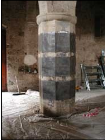
Figura 2.9 Rinforzo in CFRP, Arcivescovato di Novara 2 .
