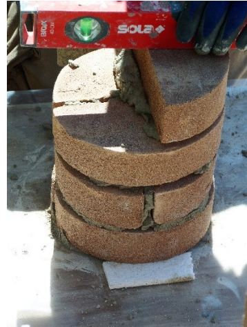
Figura 3.40 Controllo della planarità.
