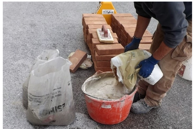
Figura 3.3 Inserimento nell’impasto della malta antica.
