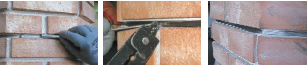
Figura 2.26 Posizionamento dei cavi in acciaio [7].
