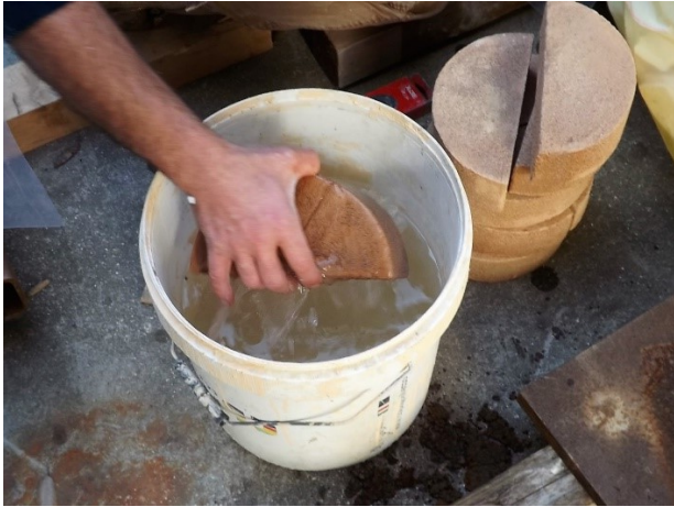
Figura 3.45 Bagnatura dei mattoni.
