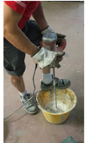
Figura 3.71 Miscelazione resina.
