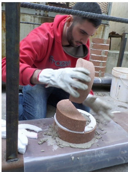
Figura 3.47 Sovrapposizione filari di mattoni.
