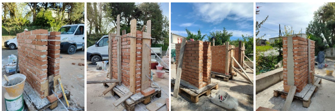
Figura 154_puntellamento delle cortine e getto del nucleo interno
