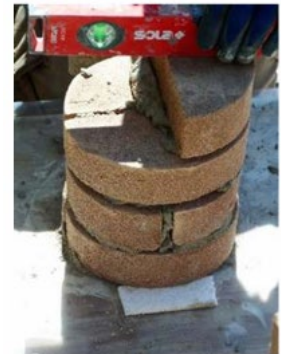
Figura 62_posa del primo strato di allettamento e controllo della planarit 
