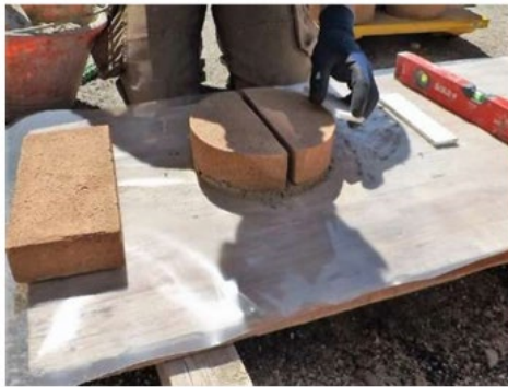
Figura 62_posa del primo strato di allettamento e controllo della planarit 
