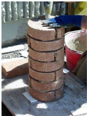
Figura 62_posa del primo strato di allettamento e controllo della planarit 
