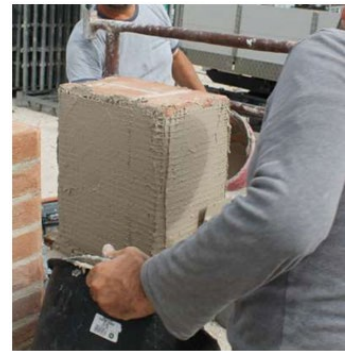
Figura 71_posa del secondo strato di rete e schiacciamento con la spatola
