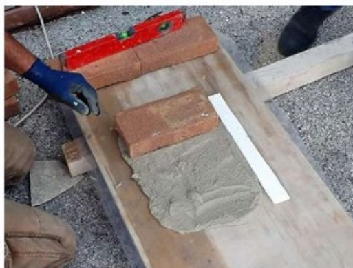
Figura 59_posa del primo strato di allettamento e controllo della planarità
