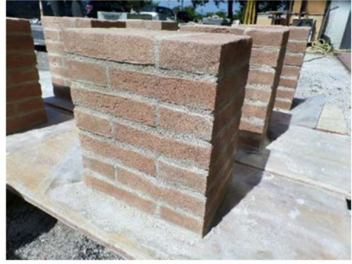
Figura 61_spazzolatura e pulizia della colonna
