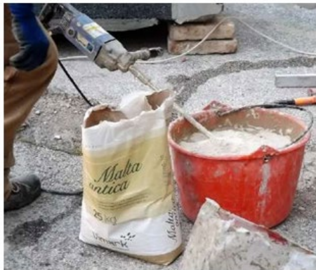
Figura 34_preparazione dell'impasto tramite miscelatore meccanico
