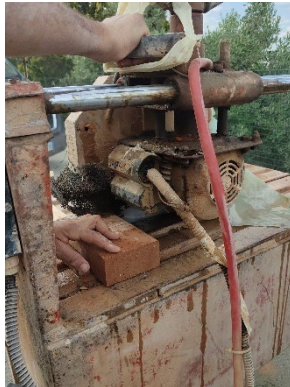
Figura 138_taglio dei mattoni tramite sega ad acqua
