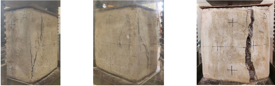
Figura 116_rilievo fotografico (RT FRCM_3)
