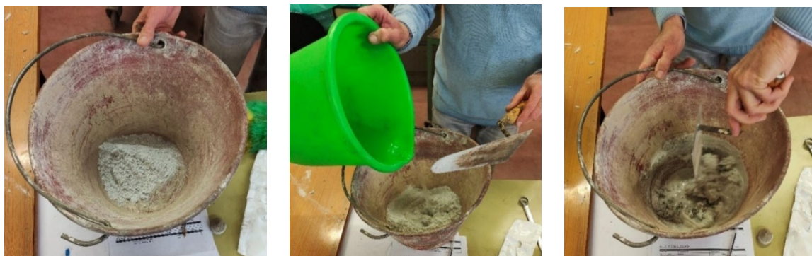
Figura 80_preparazione dell'impasto di gesso
