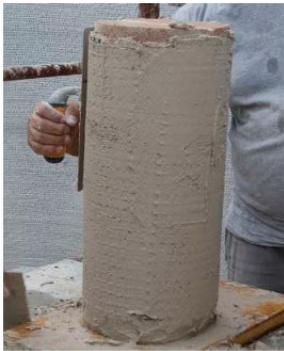
Figura 71_posa del secondo strato di rete e schiacciamento con la spatola
