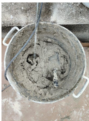
Figura 129_impasto della malta finito
