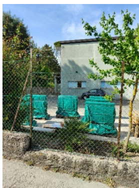
Figura 155_copertura dei muretti in caso di pioggia
