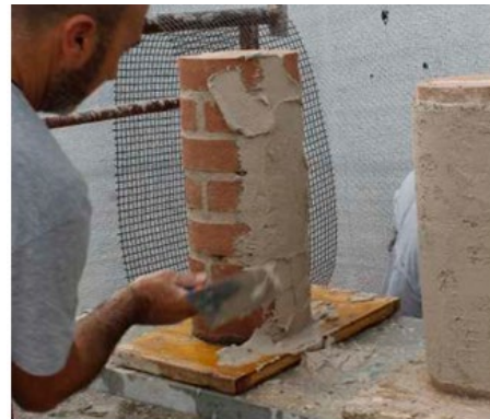
Figura 69_bagnatura della muratura e stesura del primo strato di geocalce
