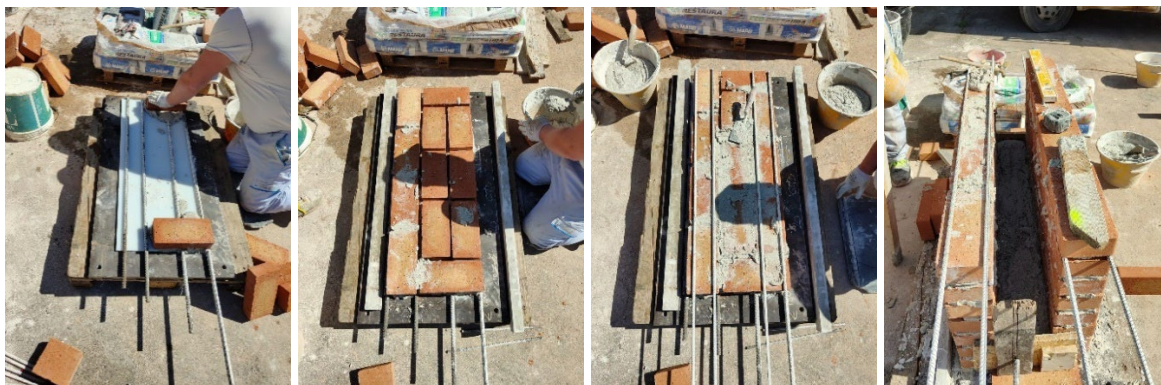
Figura 153_costruzione delle due cortine, a partire dal corso base (sx), fino al getto del nucleo interno (dx)
