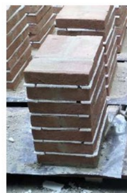
Figura 59_posa del primo strato di allettamento e controllo della planarità
