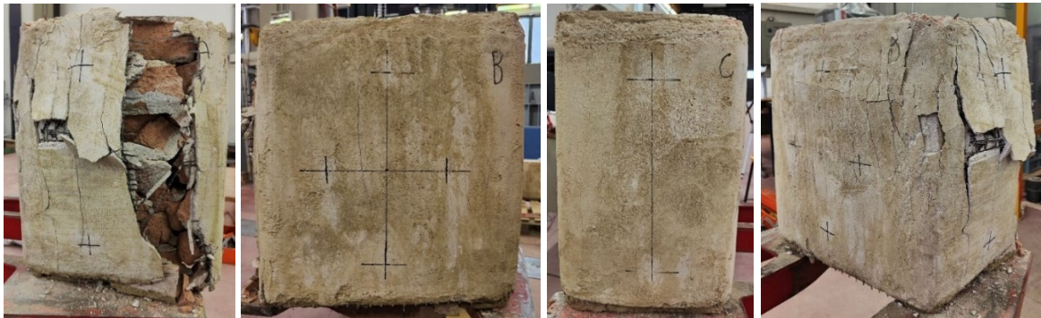
Figura 91_rilievo fotografico in seguito alla prova (RT FRCM_2)
