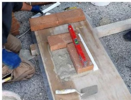
Figura 59_posa del primo strato di allettamento e controllo della planarità
