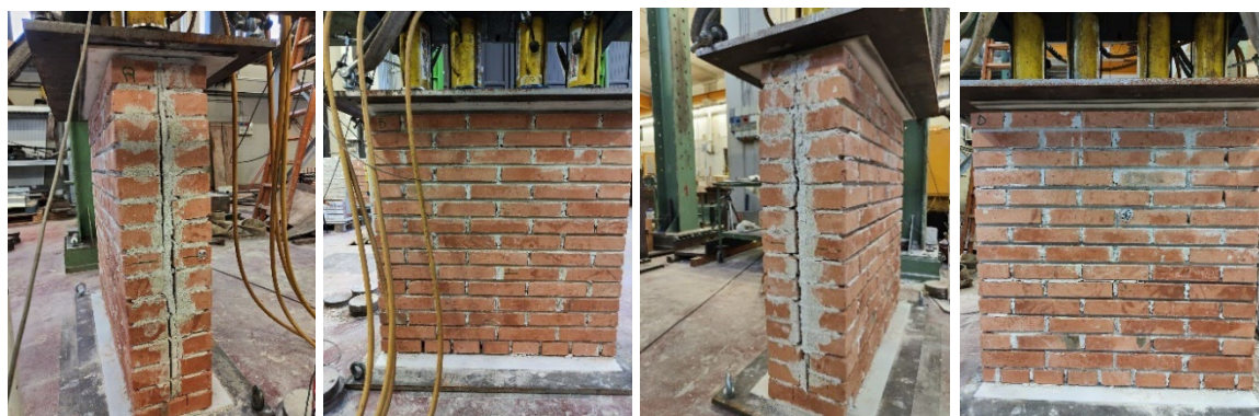
Figura 177_rilievo fotografico eseguito in seguito alla prova, facce A, B, C, D (MC_2)
