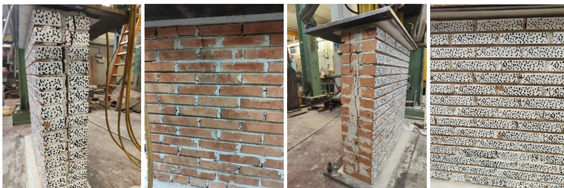
Figura 179_rilievo fotografico eseguito in seguito alla prova, facce A, B, C, D (MC_3)
