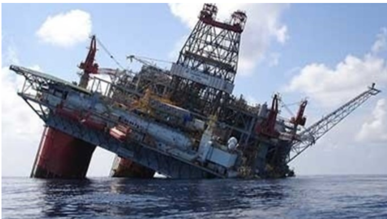
Fig.1.2 Effetti del cedimento a fatica di uno dei piloni portanti della piattaforma petrolifera "Alexander Kielland" che il 27 Marzo 1980 causò 123 morti.
