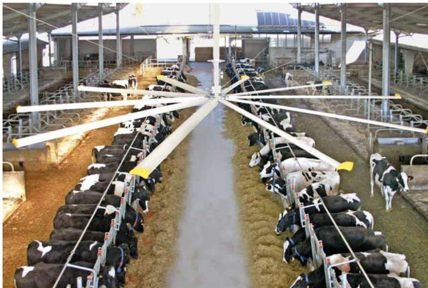
**Figura 17.** Ventilatore ad asse verticale con elica a dieci pale, situato sopra la zona di alimentazione (fonte: Ferrari et al., 2006)
