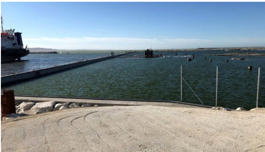
Figura 4- Vasca di colmata del porto di Ancona.
