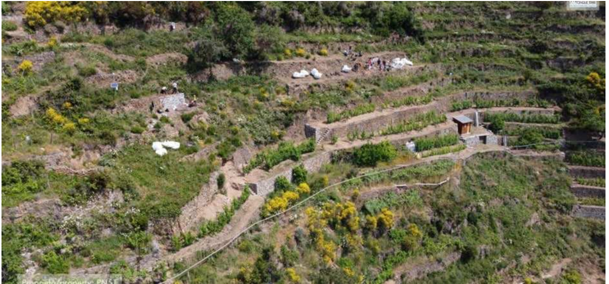
Figura 4-11 Manarola, lavori di recupero terrazzamenti
