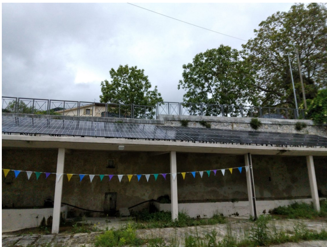
Figura 5-5: L'impianto fotovoltaico, da 20 kW, che è stato installato sopra il vecchio fontanile.
