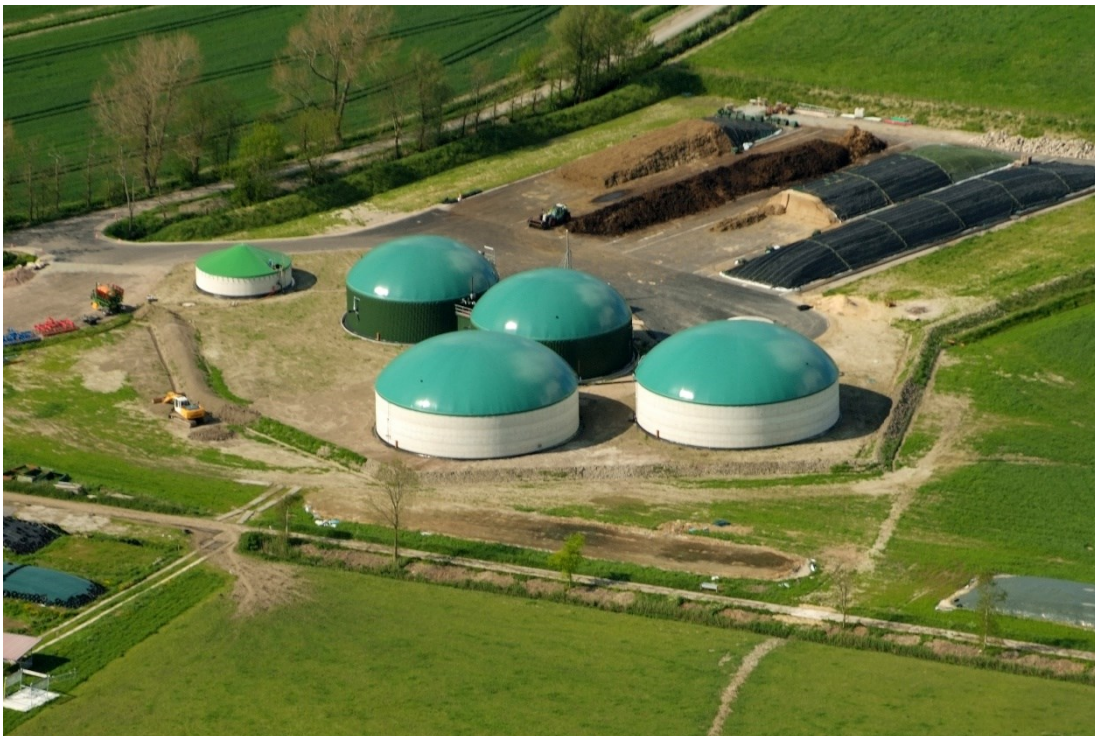
Figura 0-2: Un impianto a biogas visto dall'alto. Le strutture a cupola, che qui vediamo, sono i digestori.
