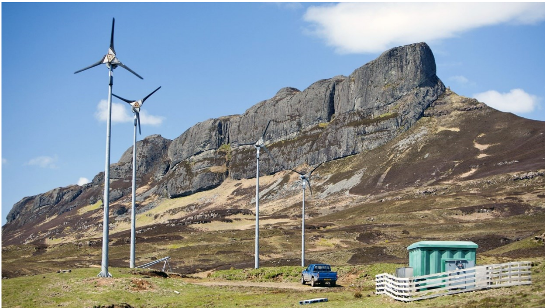
Figura 4-2: Le turbine eoliche dell'isola di Eigg.
