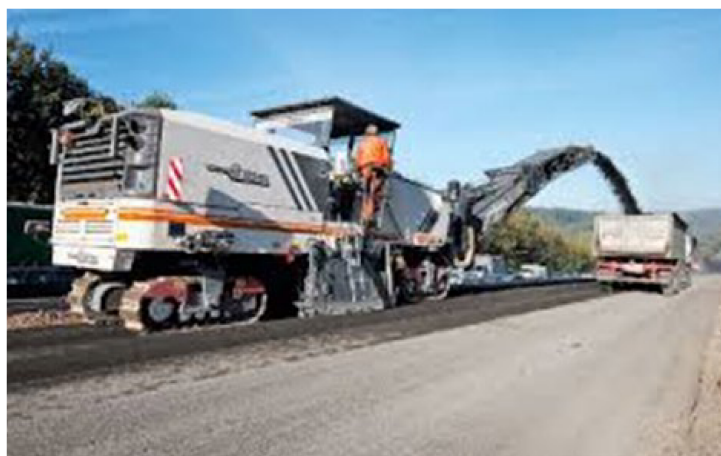
Figura 1.1: Demolizione con fresa
