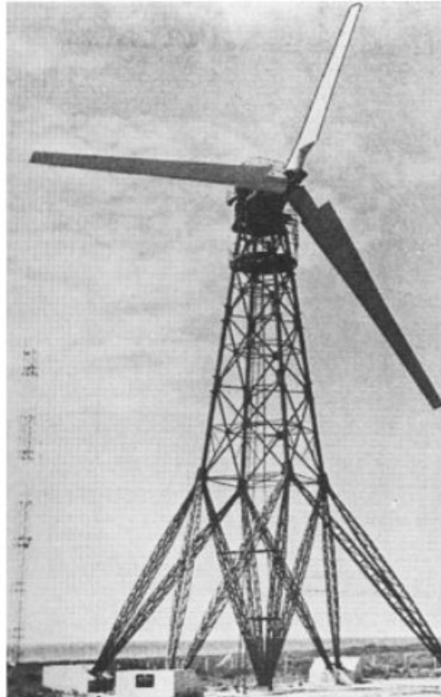
Figura 6.5 Turbina Neyrpic francese da 1.1-MW e 35-m [6]
