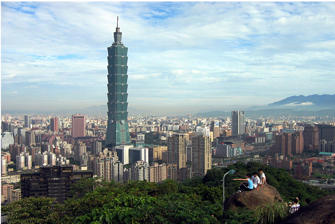
Figura 118. Sistema a massa smorzante accordata nel grattacielo Taipei 101 in Taiwan (tuned mass damper o TMD).
