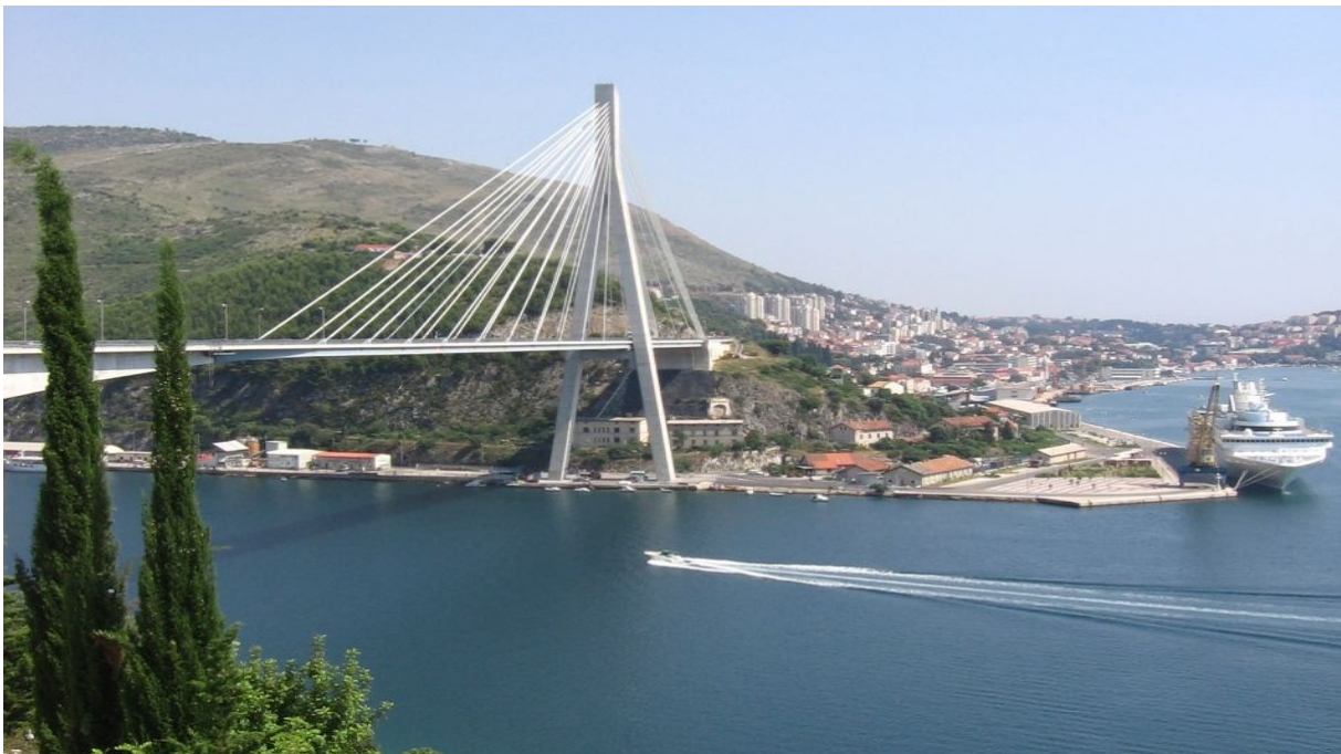
Figura 105. Applicazione di 20 smorzatori MR al ponte Dubrovnik in Croazia.
