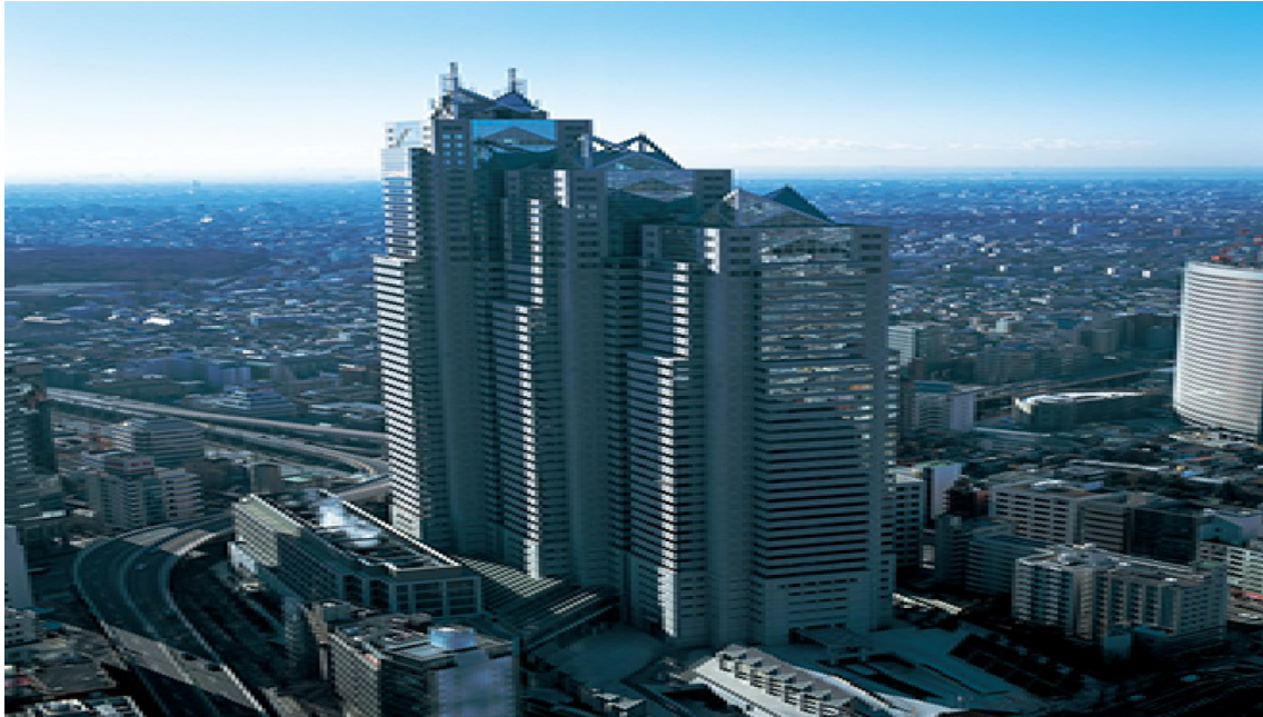
Figura 67. Applicazione di un sistema di controllo attivo a massa smorzante controllata nel Shinjuku park tower di Tokio.
