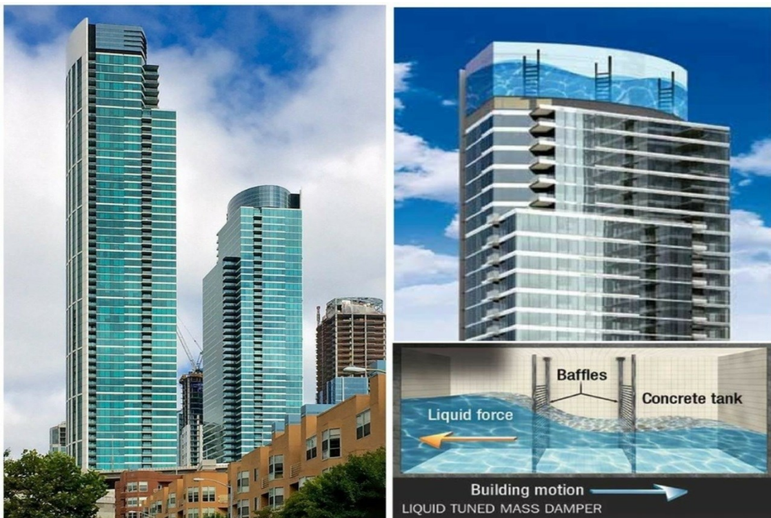
Figura 122. Sistema a massa liquida smorzante accordata nel Grattacielo One Rincon Hill South Tower in California (tuned liquid damper o TLD).
