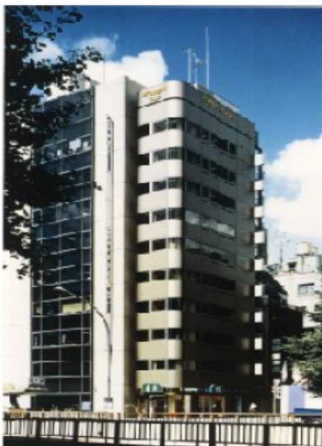
Figura 68. Applicazione di un sistema di controllo attivo a massa smorzante controllata nel Kyobashi Seiwa Building di Tokyo.
