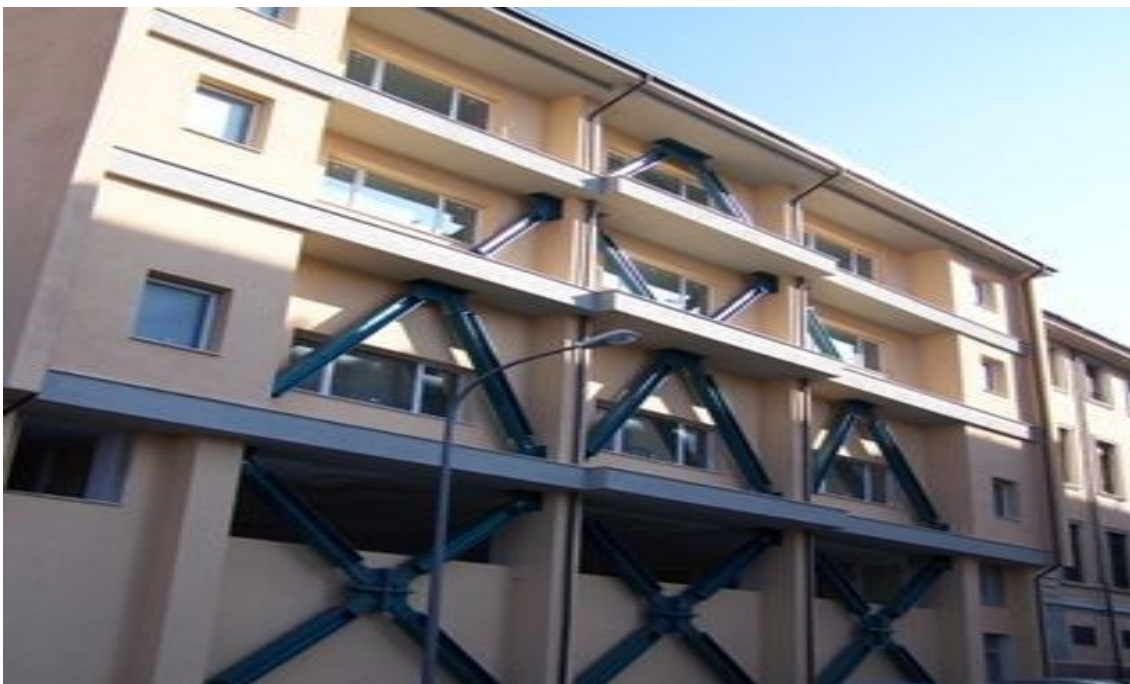
Figura 76. Applicazione di controventi dissipativi su una struttura.
