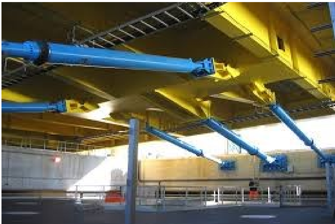
Figura 92. Controventi dissipativi con fluidi elettroreologici.
