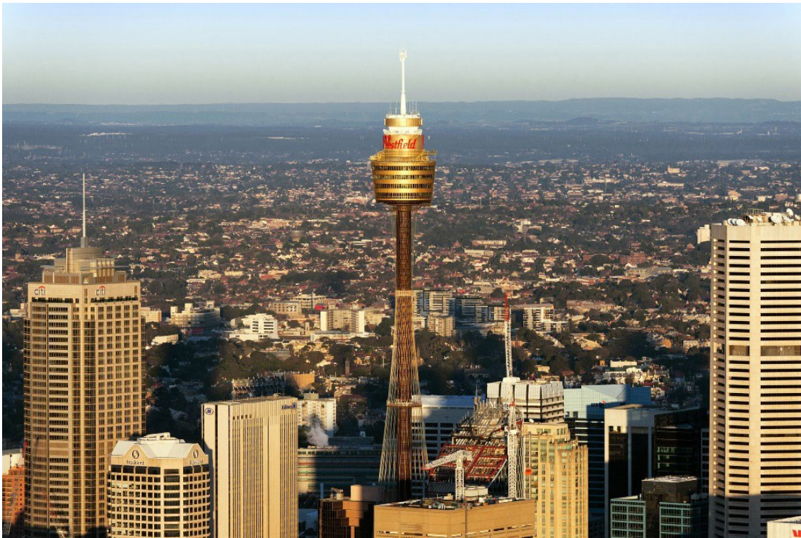
Figura 119. Sidney Tower dotata di un sistema a massa smorzante accordata (tuned mass dumper o TMD).
