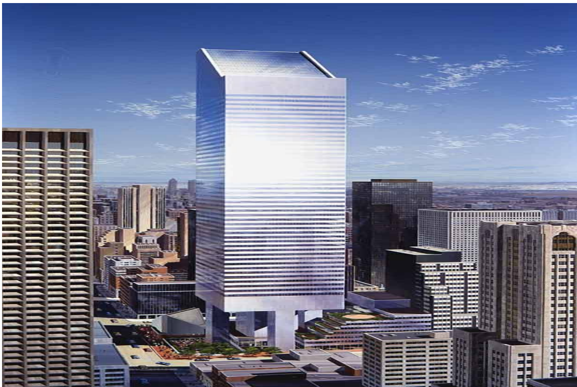
Figura 120. Citigroup Center a New York dotato di un sistema a massa smorzante accordata (tuned mass dumper o TMD).
