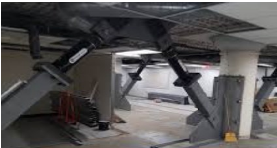
Figura 74. Smorzatore viscoso passivo.
