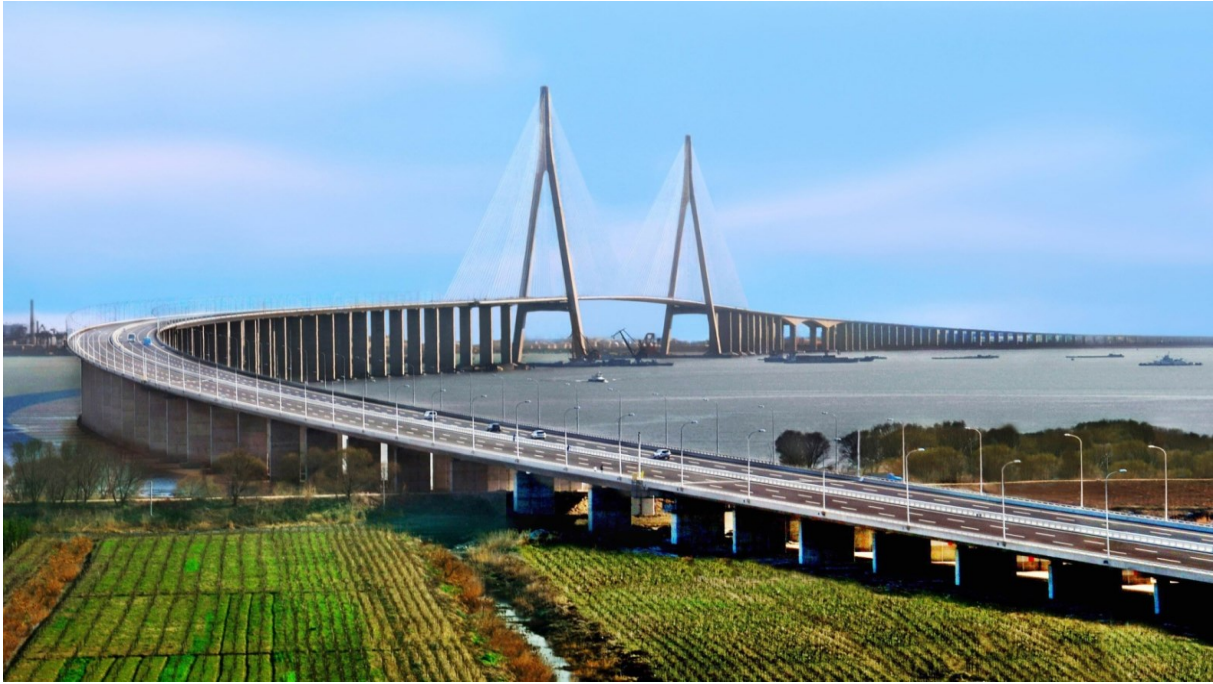
Figura 104. Applicazione di smorzatori MR al Ponte Sutong in Cina.
